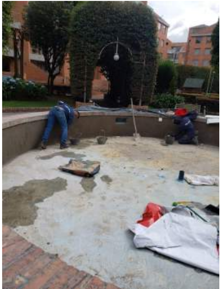
Arreglo de fuente plazoleta
