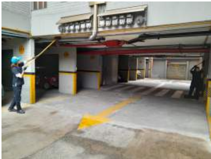
Limpieza general de telarañas
