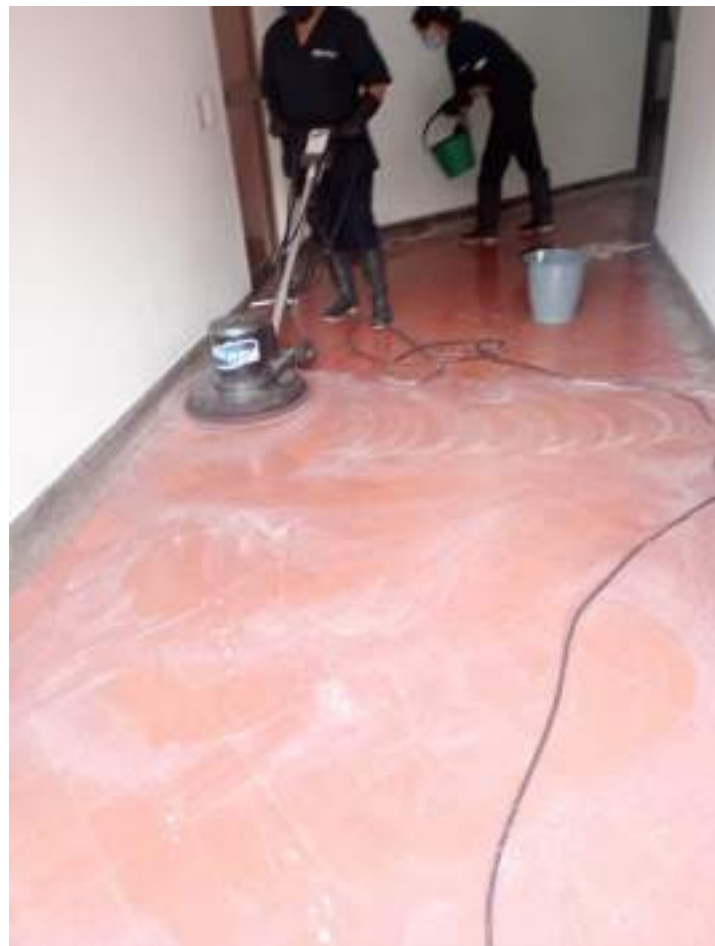
Decapado y encerado de pisos entradas a las torres
