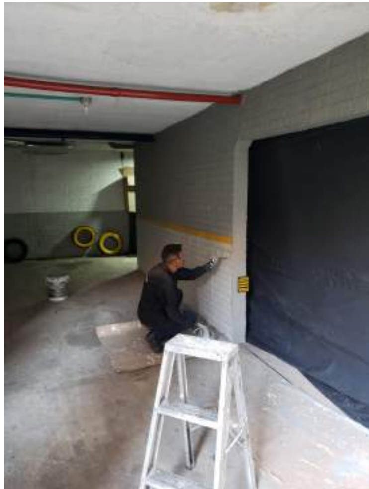
Se avanza en pintura de parqueaderos sótanos
