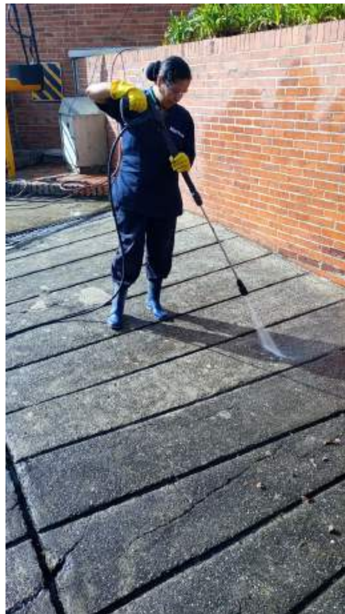
Lavado rampas portería norte y portería sur
