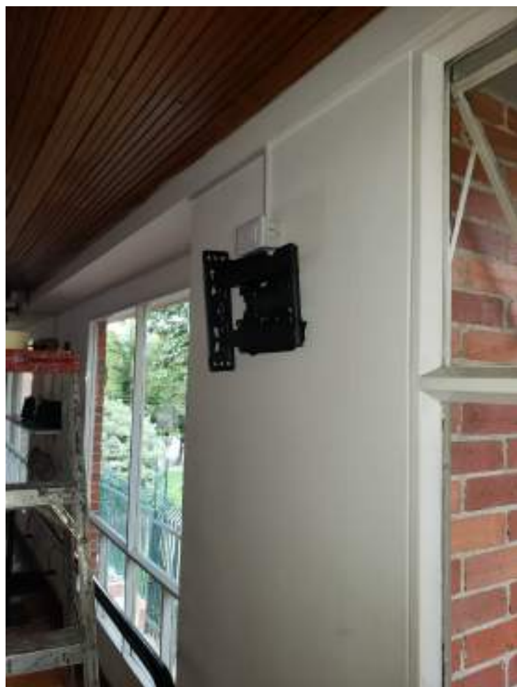
Se instala soporte para Tv en el gimnasio, se deja también ins...
