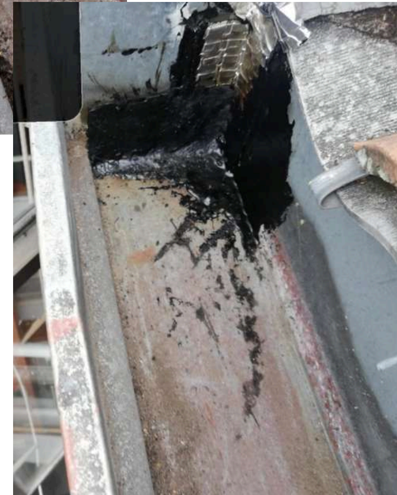
9-501 ARREGLO FILTRACIÓN ALTURAS
