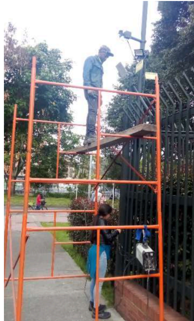
INSTALACIÓN DE REFLECTORES PERIMETRALES Y RACK EN PORTERÍA SUR
