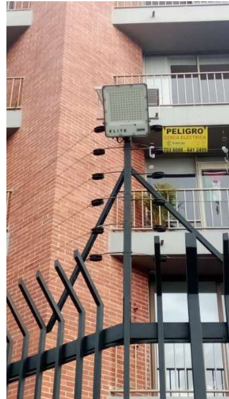
INSTALACIÓN DE REFLECTORES PERIMETRALES Y RACK EN PORTERÍA SUR
