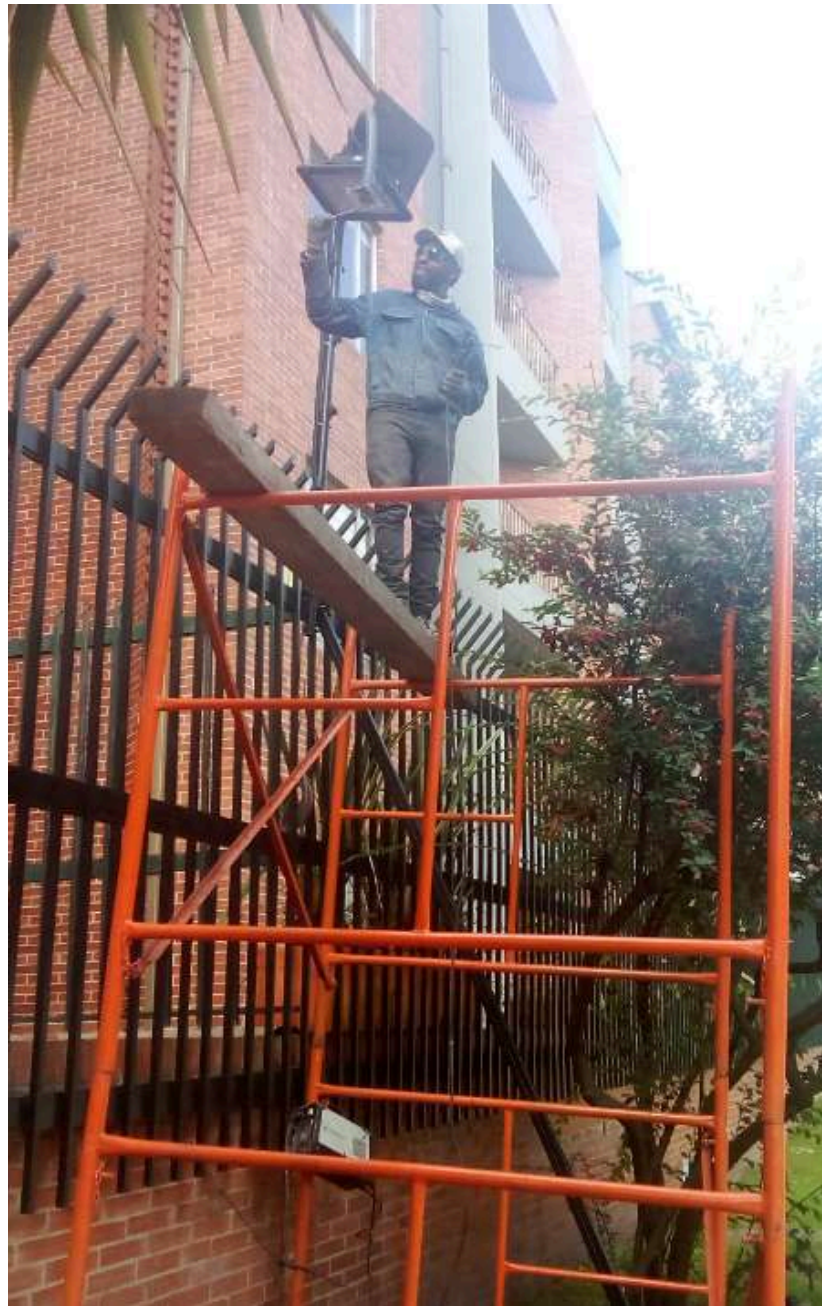
INSTALACIÓN DE REFLECTORES PERIMETRALES Y RACK EN PORTERÍA SUR
