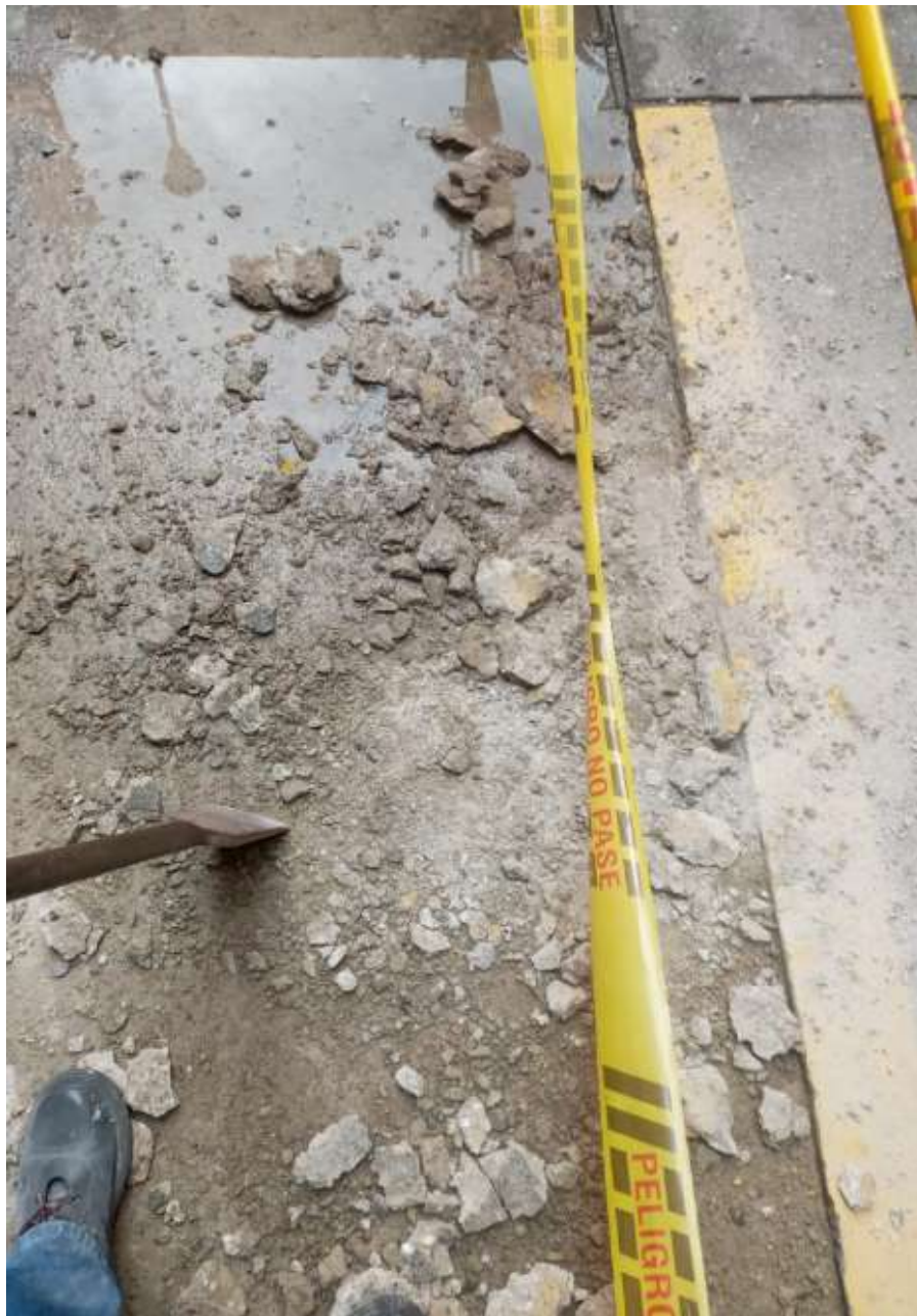
4-102 ARREGLO PISO PARQUEADERO ENTRE TORRES 4 Y 5
