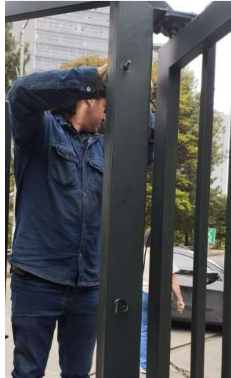
INSTALACIÓN CONTROL DE ACCESO PORTERÍA SUR
