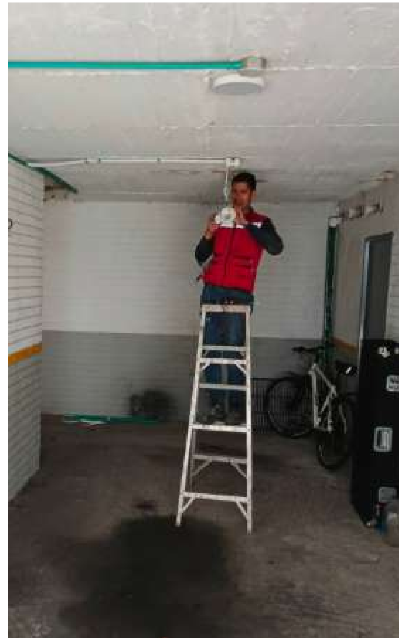
1-401 INSTALACIÓN SENSOR INDEPENDIENTE
