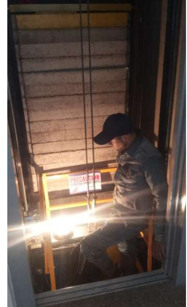
ARREGLO CABLE DE TRACCIÓN ASCENSOR T6
