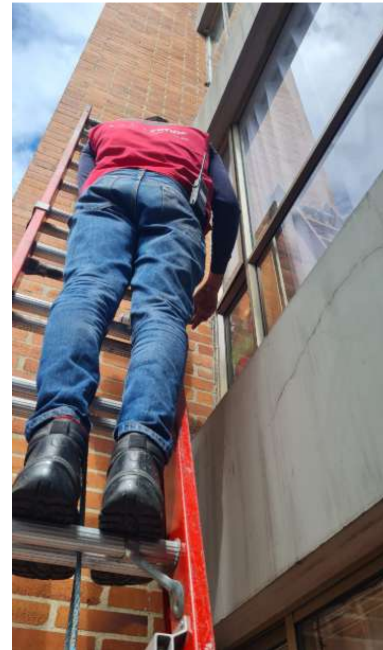
10-203 SELLADO DE VENTANAS
