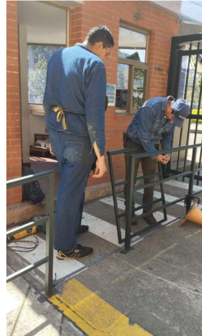
INSTALACIÓN DE PUERTA CORREDIZA EN BARANDA PEATONAL
