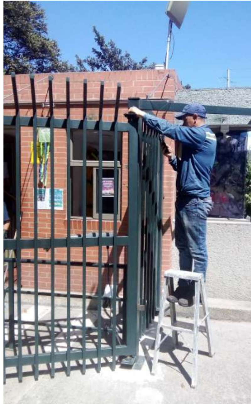
SELLAMIENTO DE LUCES PARA EVITAR CORROSIÓN EN LA PUERTA POR PARTE DE VELCO INGENIERÍA
