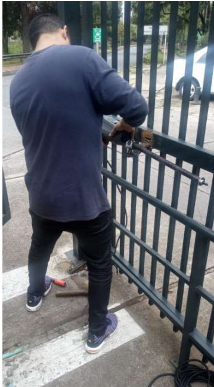
CALIBRACIÓN BRAZO HIDRAULICO PUERTA VEHICULAR SUR
