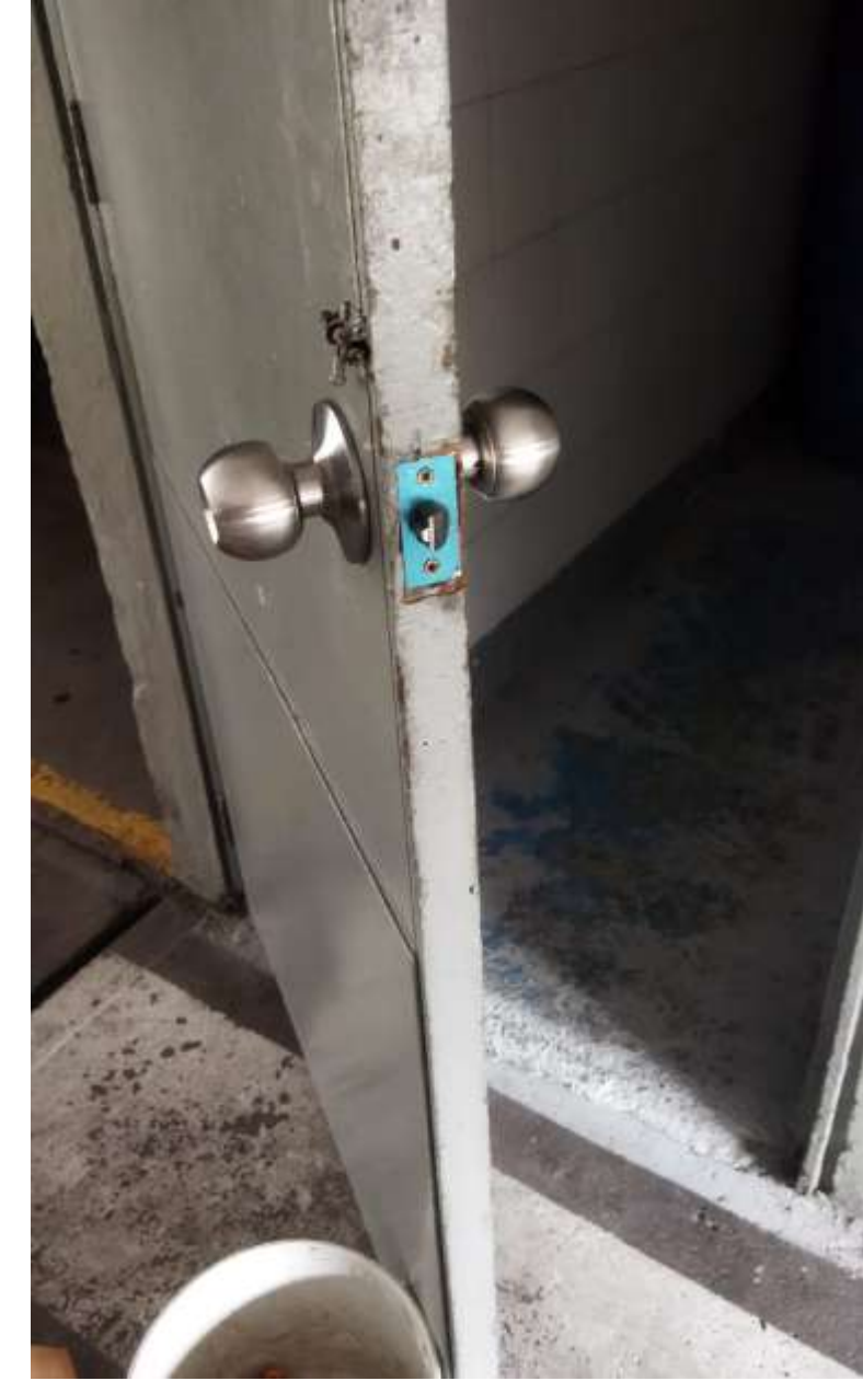
CAMBIO CHAPAS PUERTA SHUT T 4 Y 7
