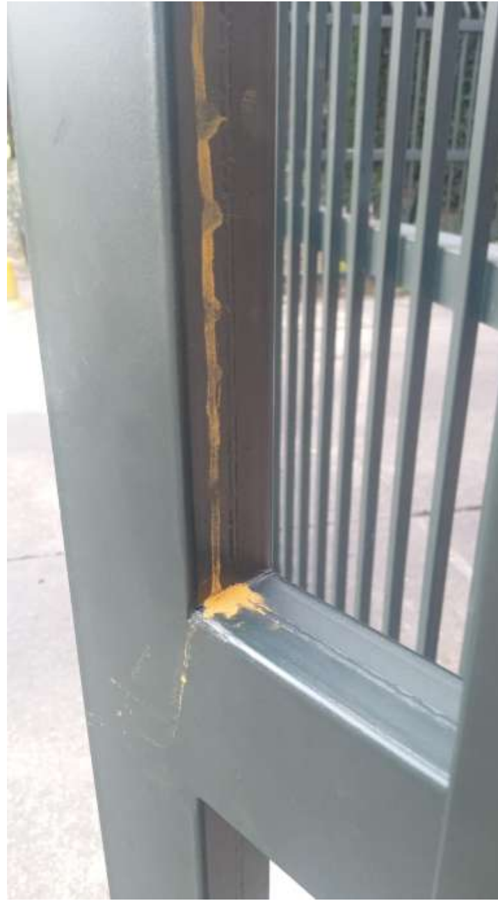
SELLAMIENTO DE LUCES PARA EVITAR CORROSIÓN EN LA PUERTA POR PARTE DE VELCO INGENIERÍA
