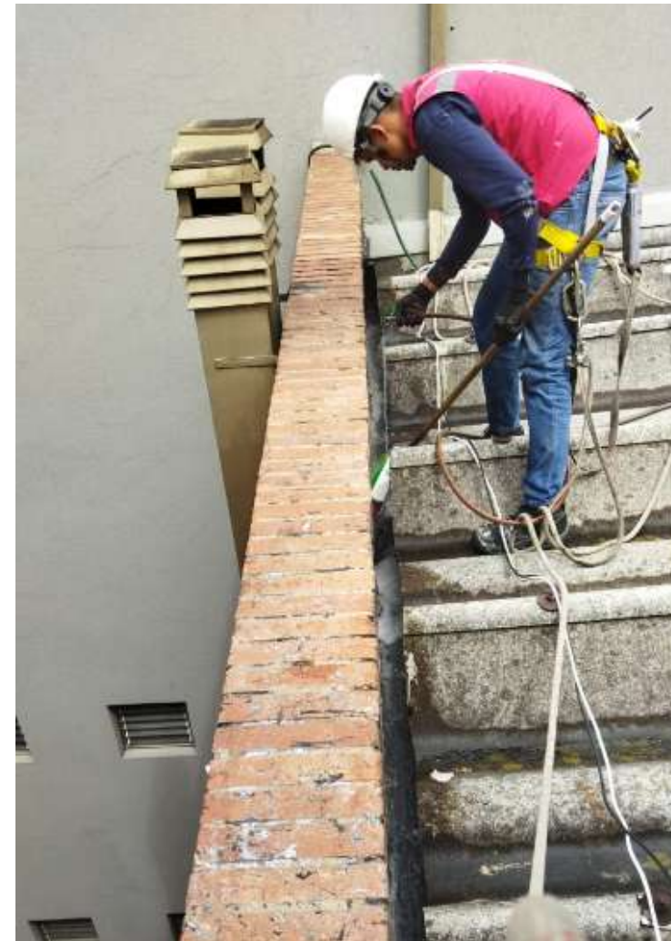
MANTENIMIENTO VIGACANALES T6 Y T7
