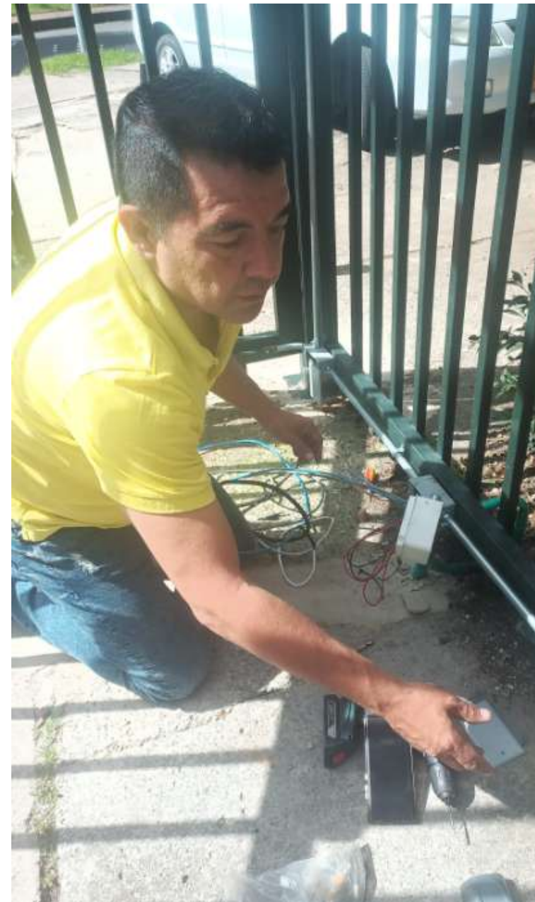
CALIBRACIÓN BRAZO HIDRAULICO PUERTA VEHICULAR SUR
