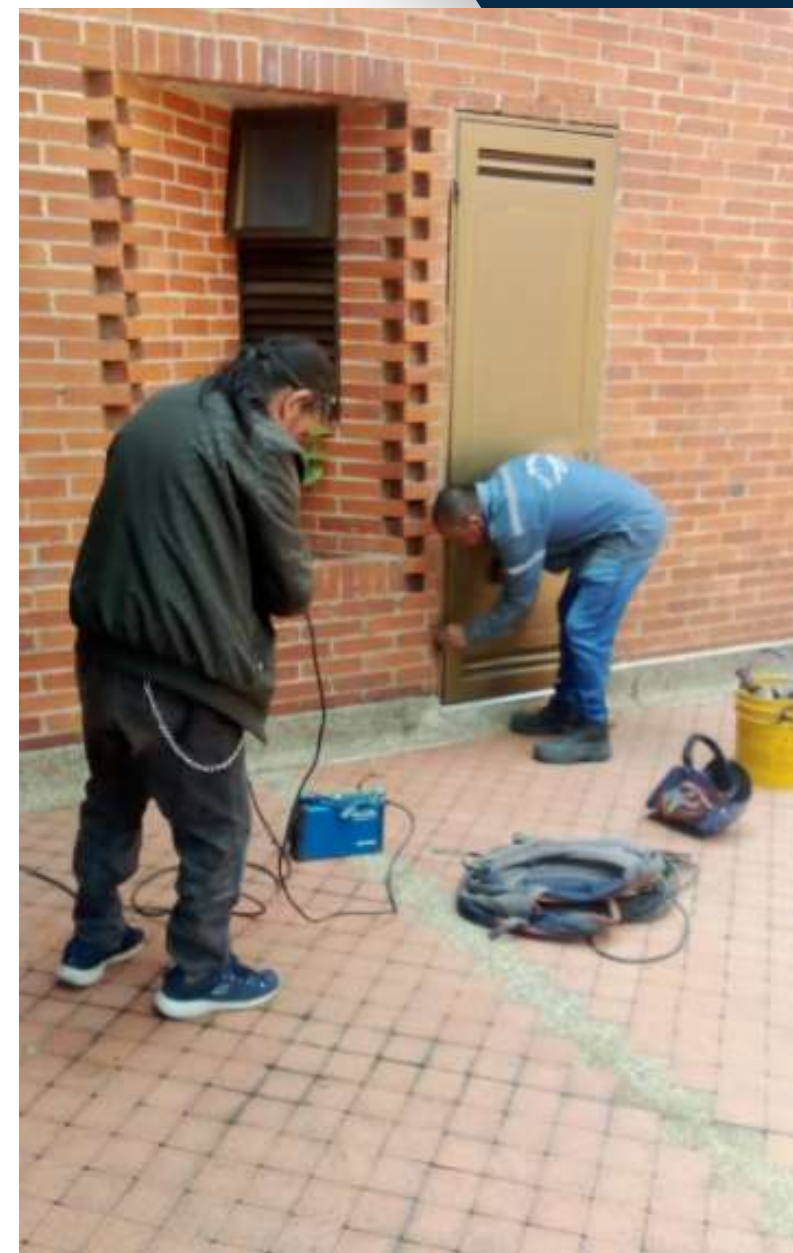
SOLDADURA DE PUERTA CAÍDA DEL BAÑO DE PERSONAL
