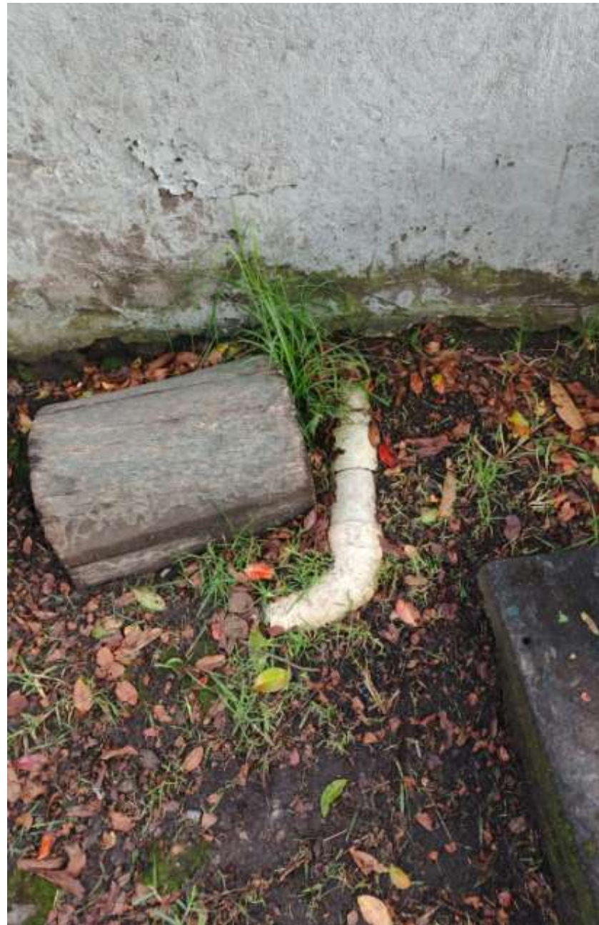
8-301 tubería expuesta en la zona del parque
