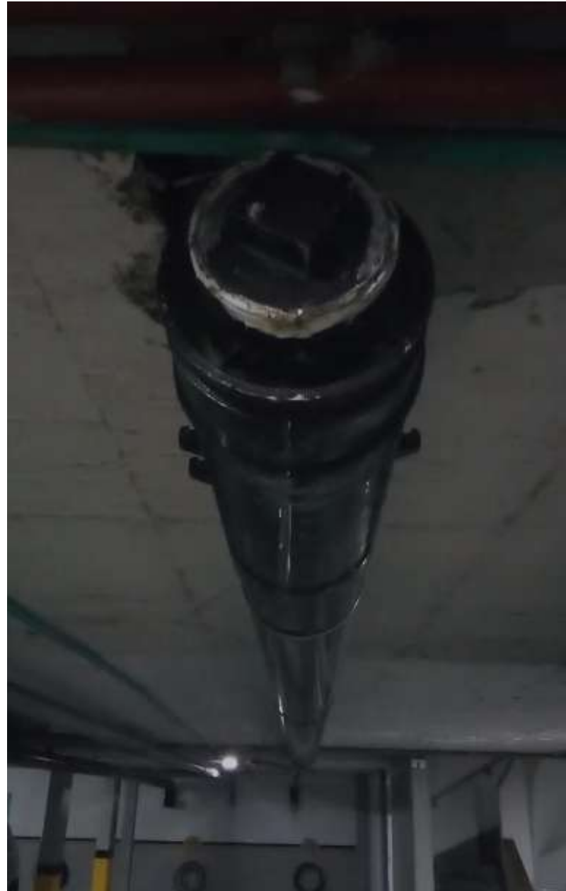
Arreglo filtración tubería de aguas negras
