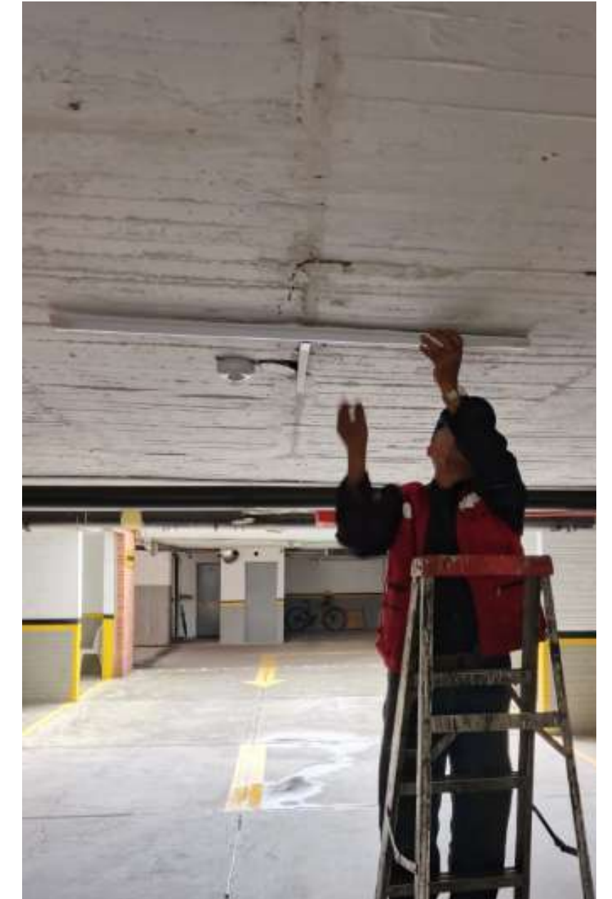
Ajuste de lámparas fundidas y caídas parqueaderos
