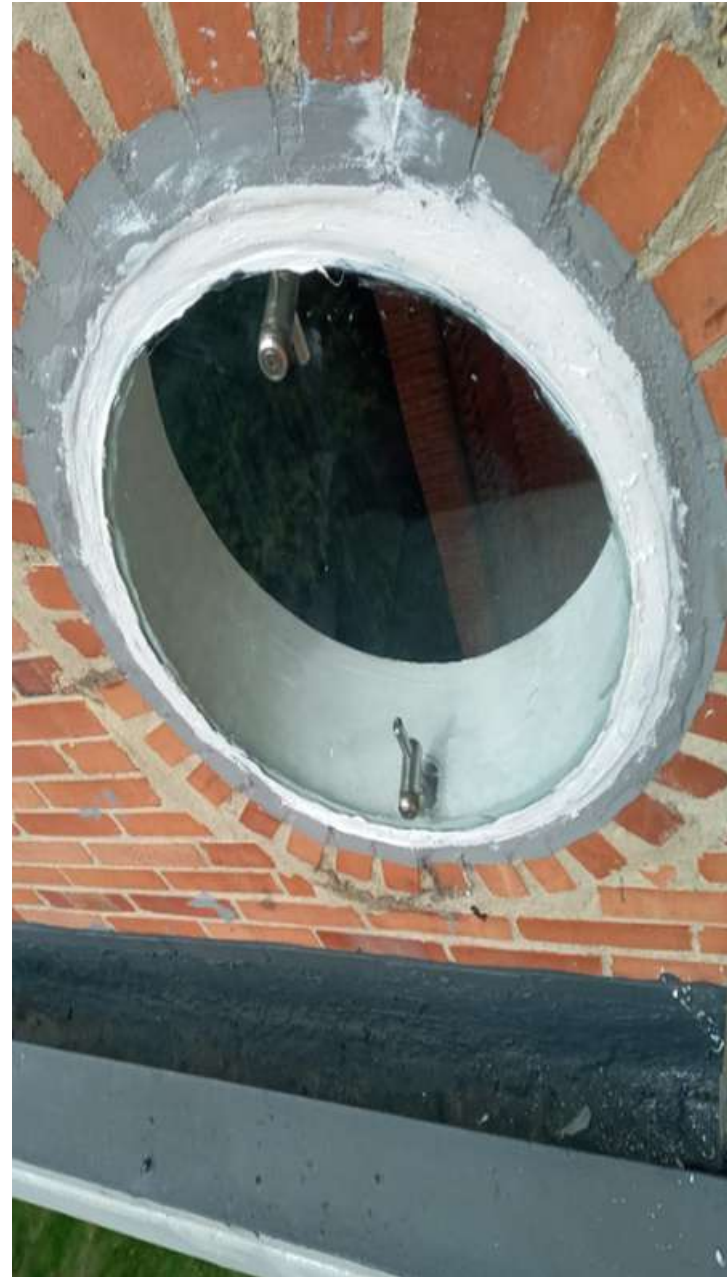
9-502 Impermeabilización ventanas
