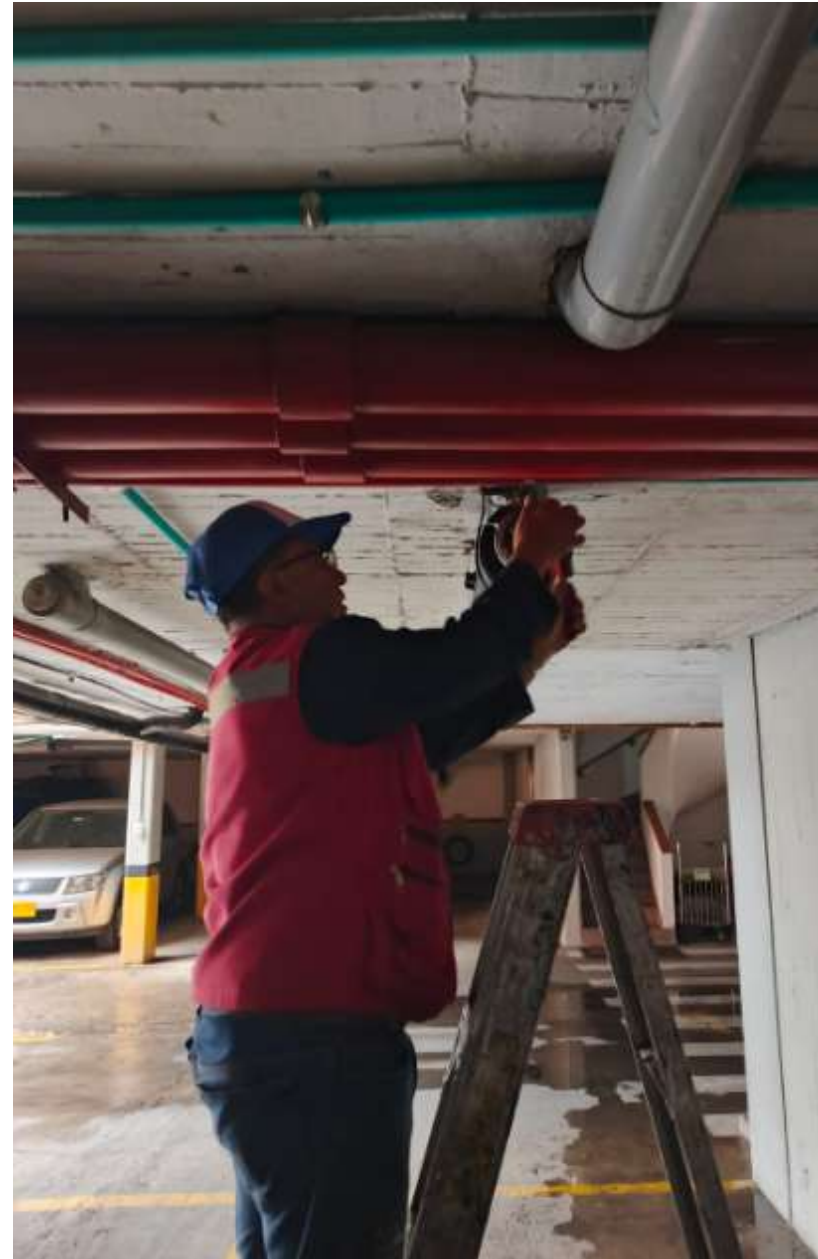
Arreglo filtración tubería de aguas negras
