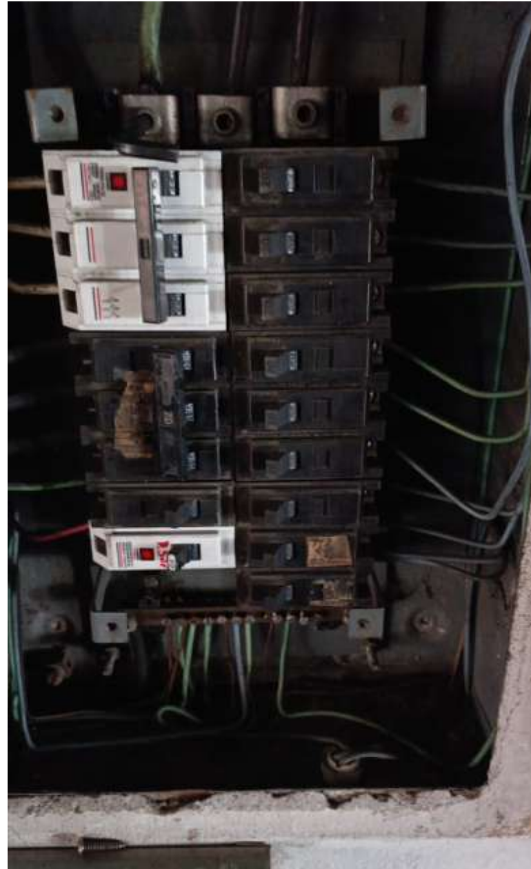
CAMBIO DE PIN DE CORTE POR CORTO EN ASCENSOR T8
