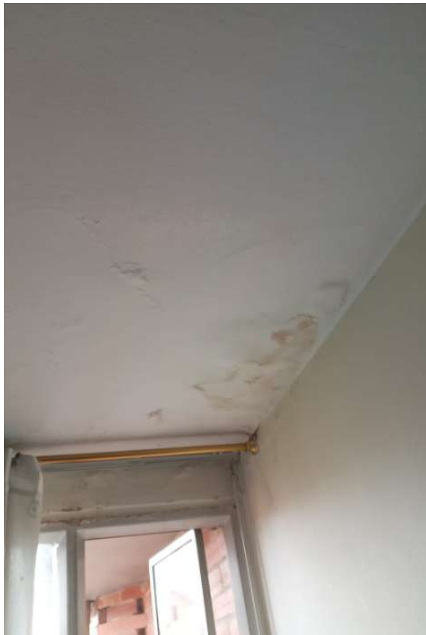
6-504 FILTRACIÓN ALCOBA Y JARDINERA
