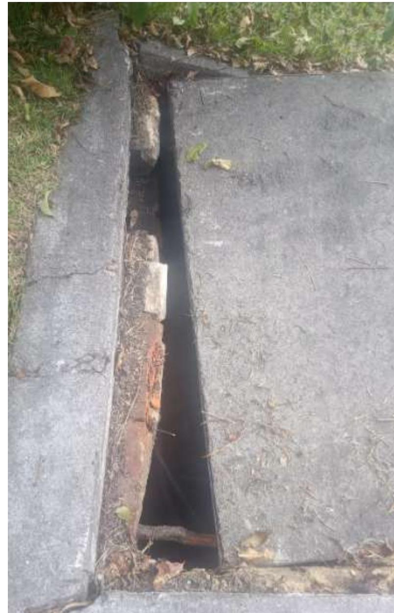
SE REPORTA TAPA DE SUB-ESTACIÓN ELÉCTRICA LEVANTADA.
