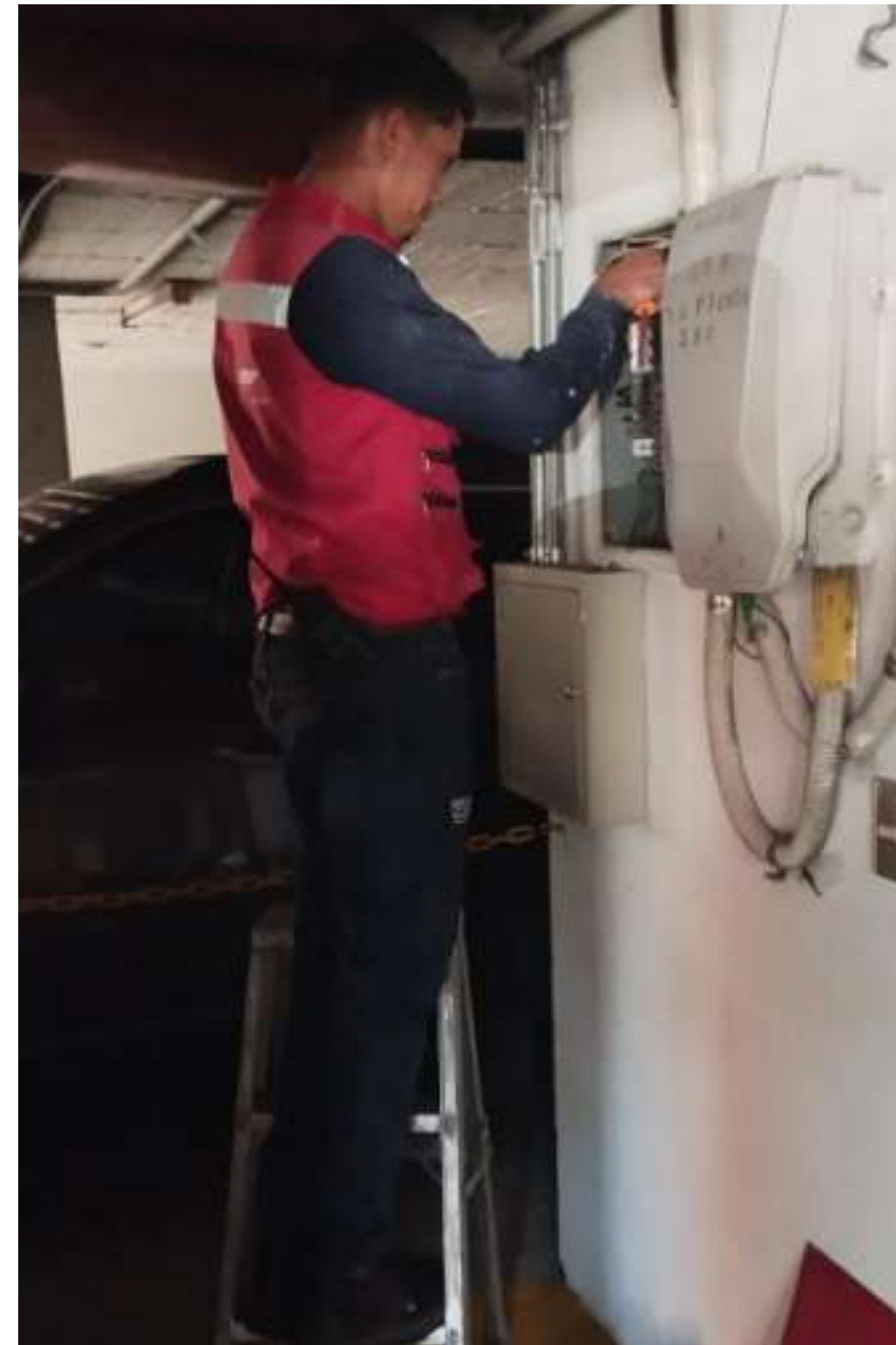
CAMBIO DE PIN DE CORTE POR CORTO EN ASCENSOR T8
