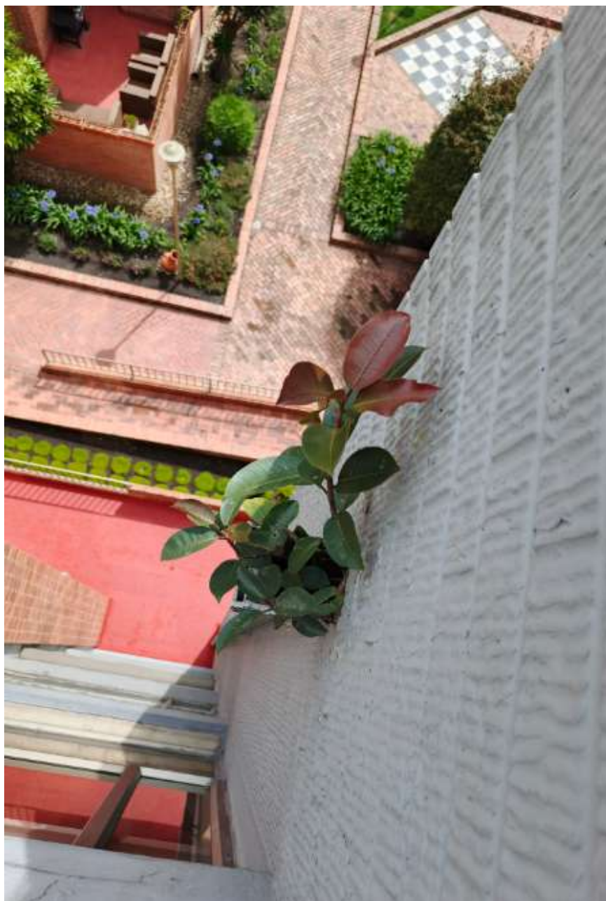
2-504 RETIRO DE PLANTA EN CANAL AGUAS LLUVIAS
