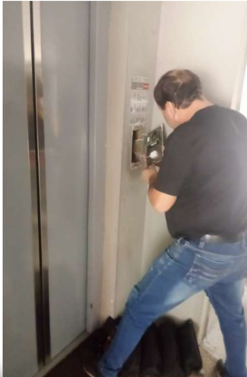
MANTENIMIENTO CORRECTIVO BOTÓN HALL SÓTANO TORRE 5
