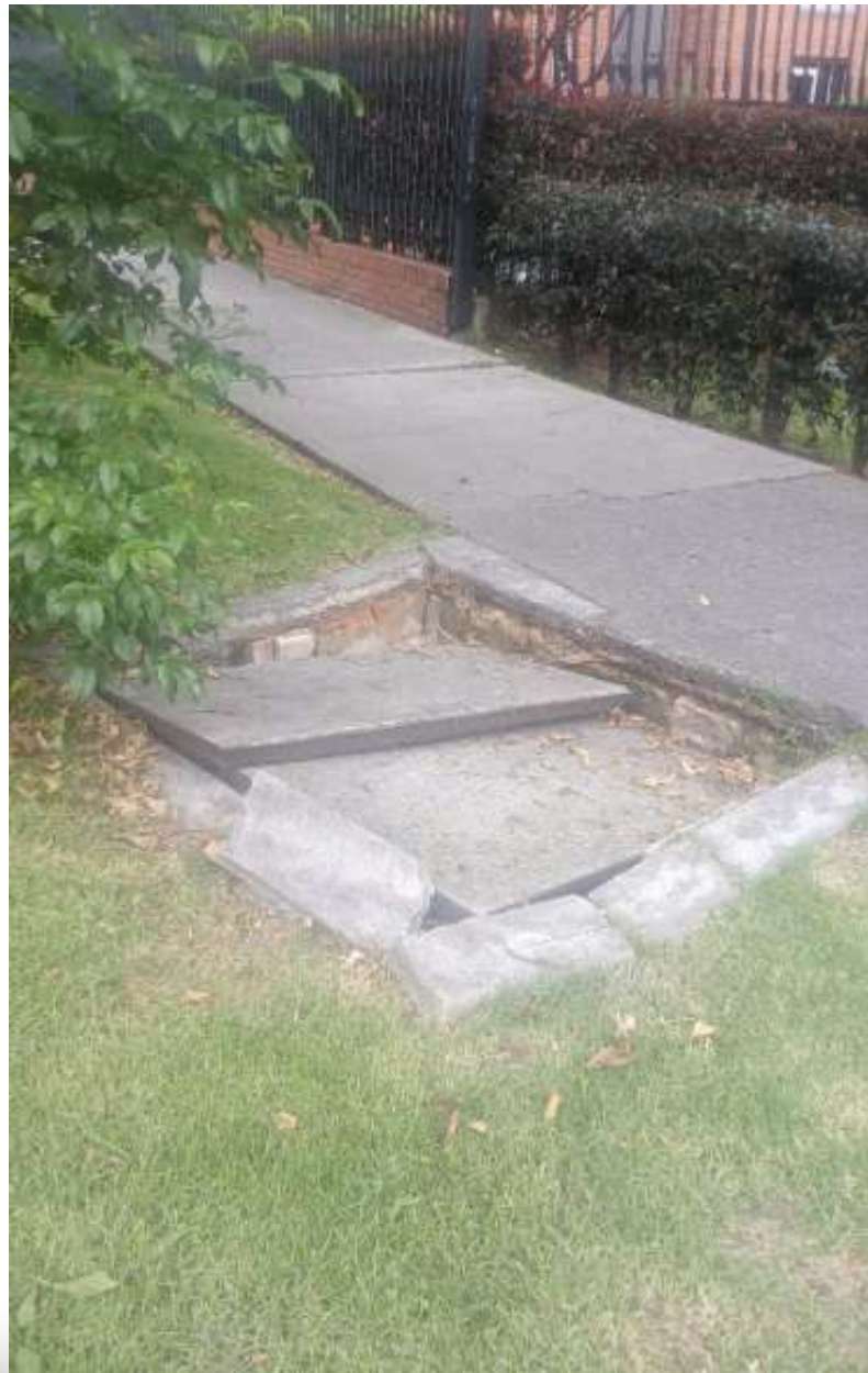
SE REPORTA TAPA DE SUB-ESTACIÓN ELÉCTRICA LEVANTADA.
