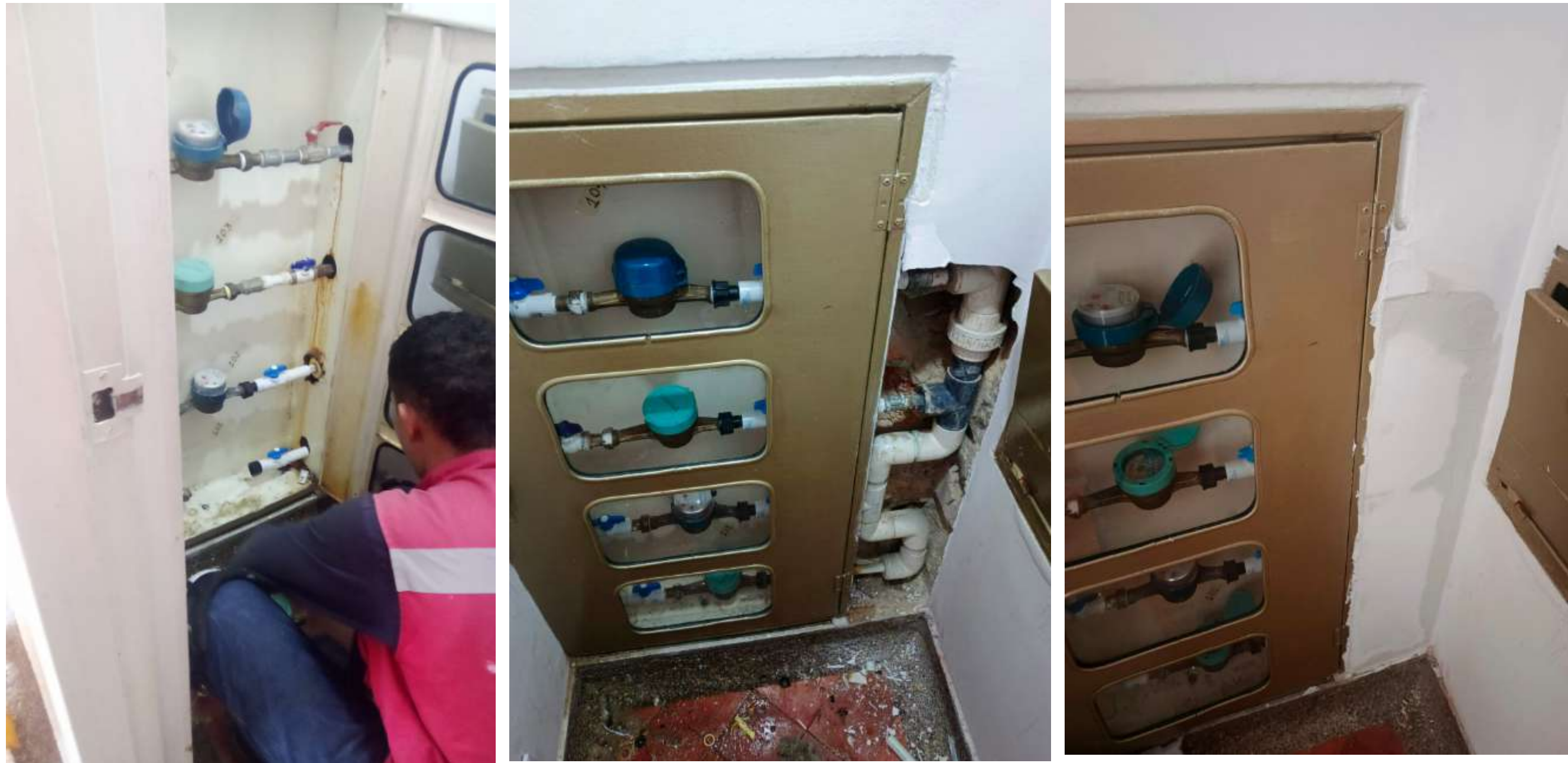
T5 PRIMER PISO. CAMBIOS DE MIPLES DE LA FLAUTA GALVANIZADO A PVC
