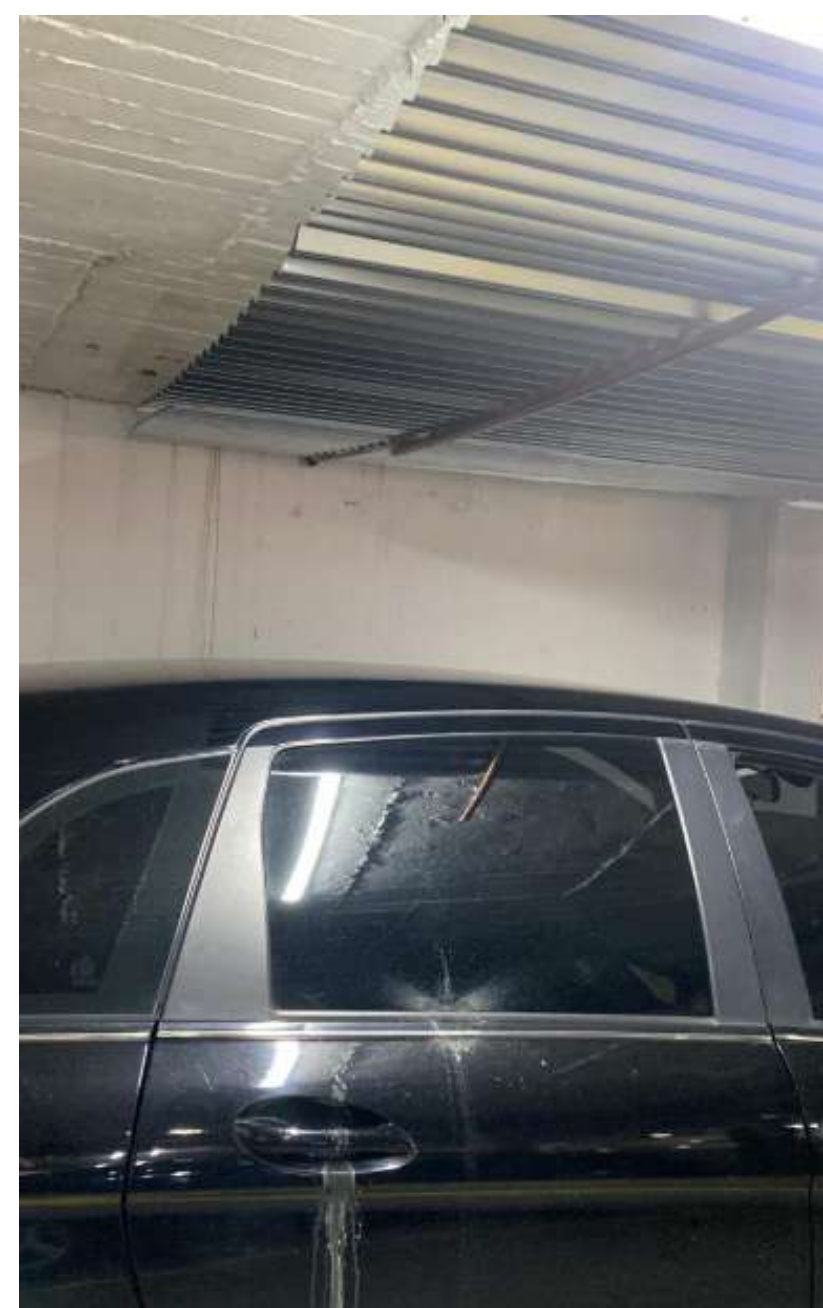
6-304 TECHADO EN ZIN POR FILTRACIÓN EN PARQUEADERO
