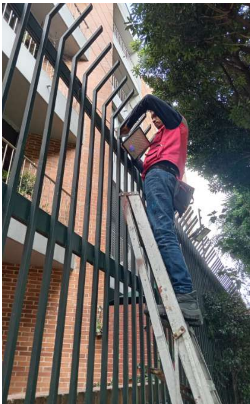
INSTALACIÓN REFLECTORES SOLARES DEL PERIMETRO
