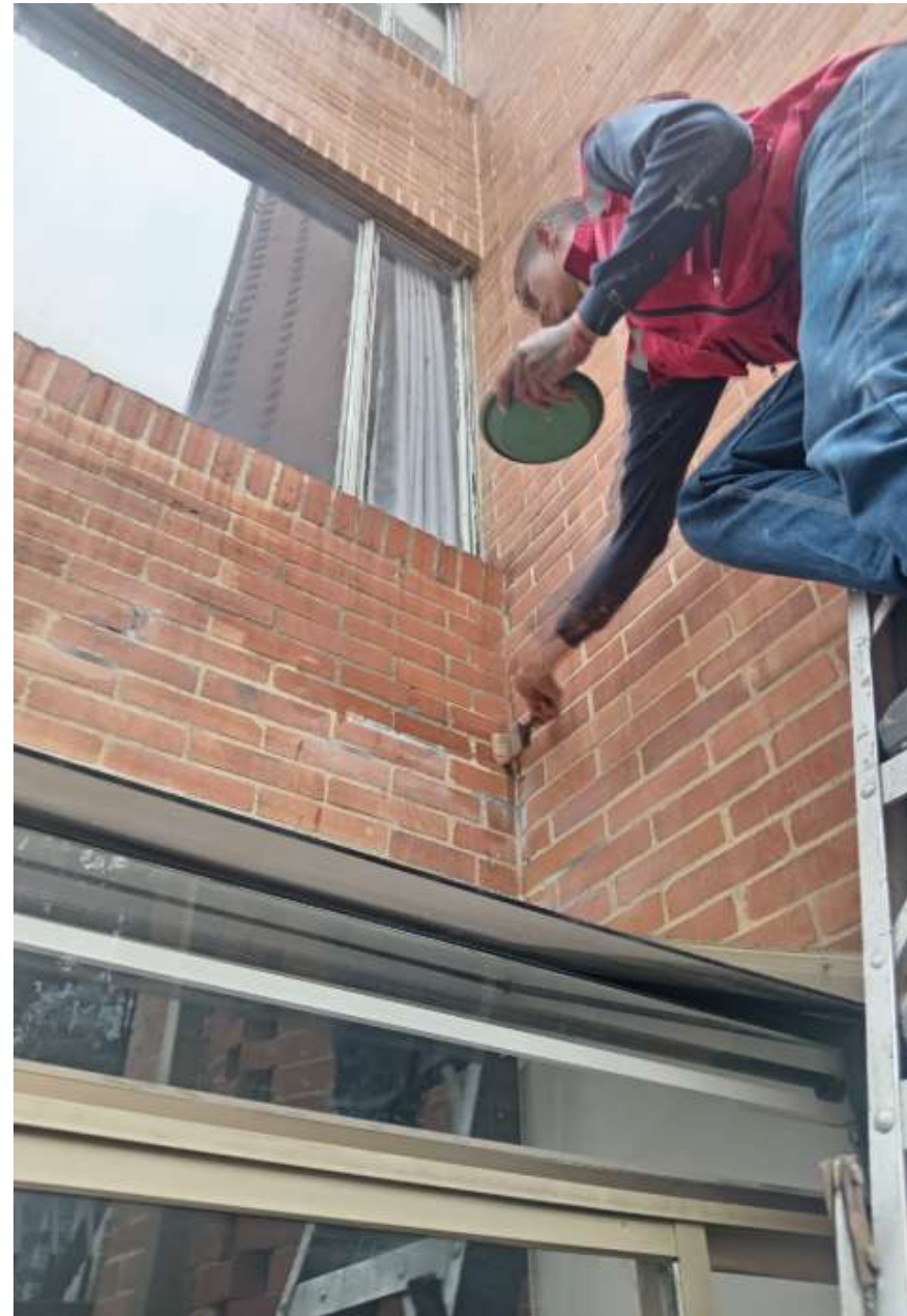
10-103 Y 10-203 IMPERMEABILIZACIÓN FACHADA HUMEDAD INTERNA
