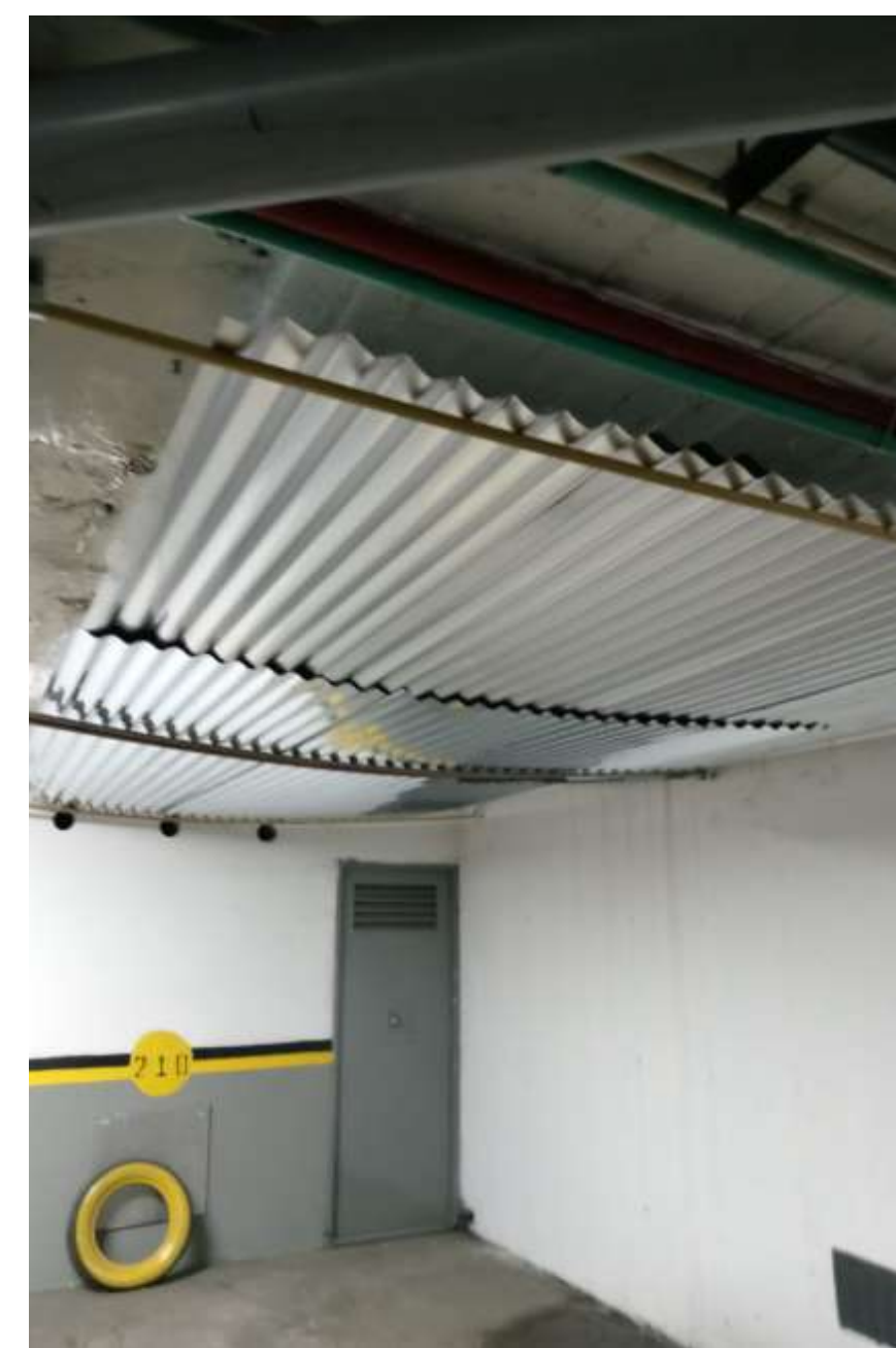
6-304 TECHADO EN ZIN POR FILTRACIÓN EN PARQUEADERO
