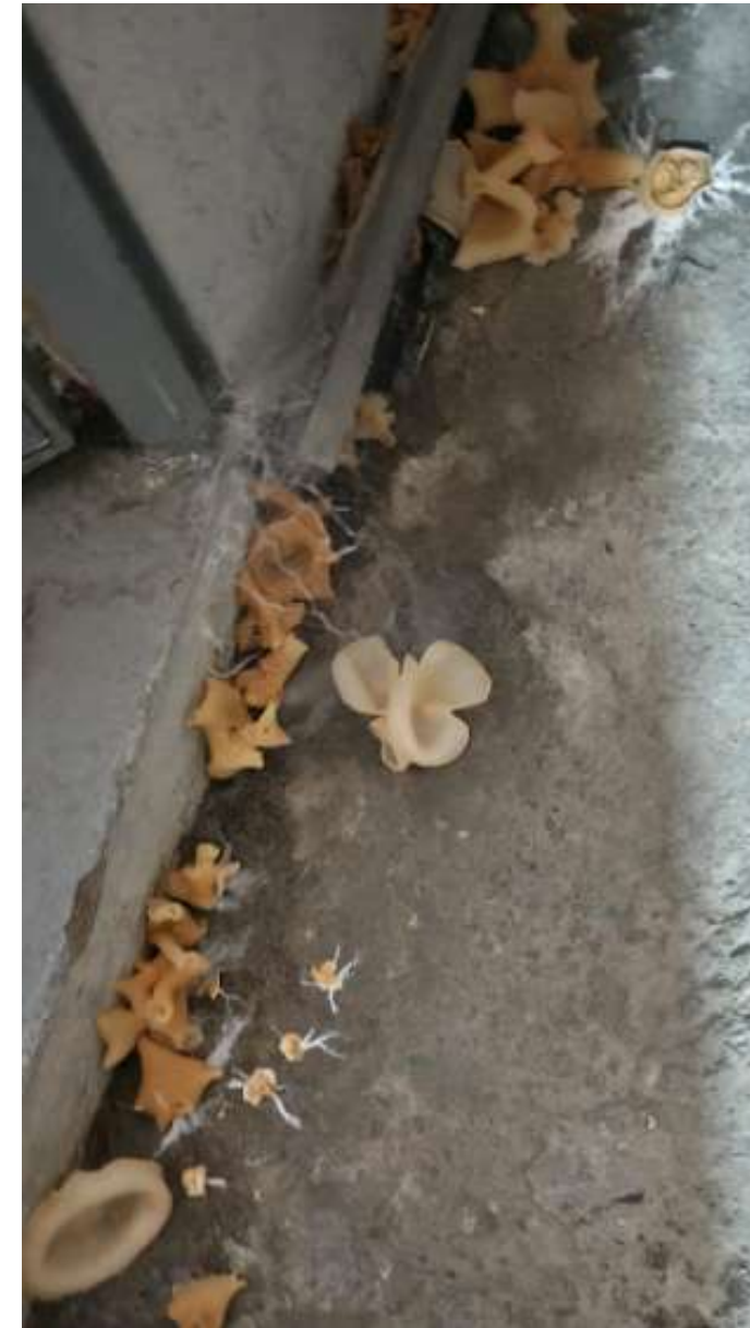
4-202 HUMEDAD FUERTE CAUSADA POR TERRAZA 4-102
