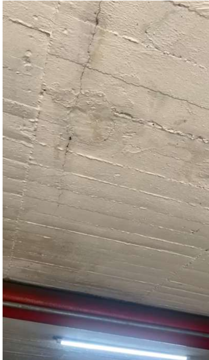
6-502 EXPLORACIÓN FILTRACIÓN EN PARQUEADERO #164
