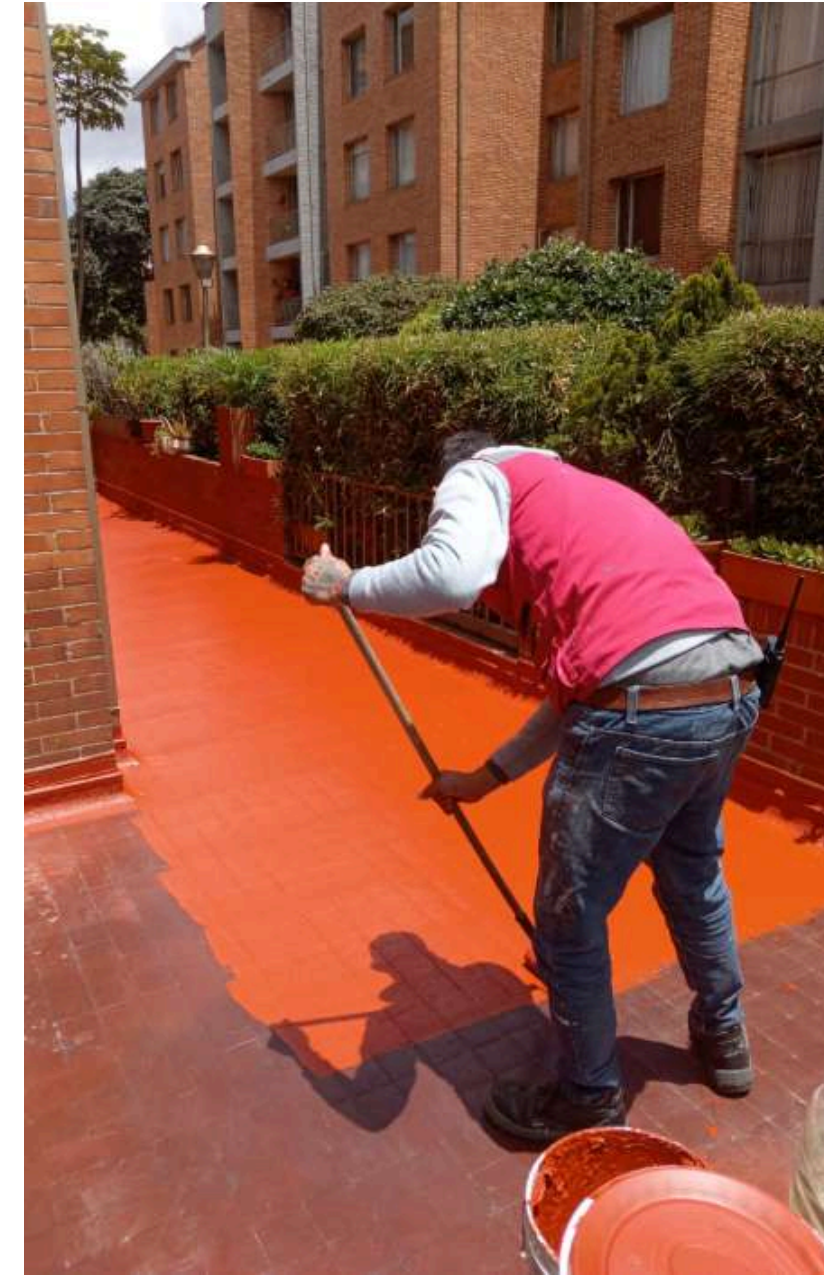
IMPERMEABILIZACIÓN TERRAZA 3-103
