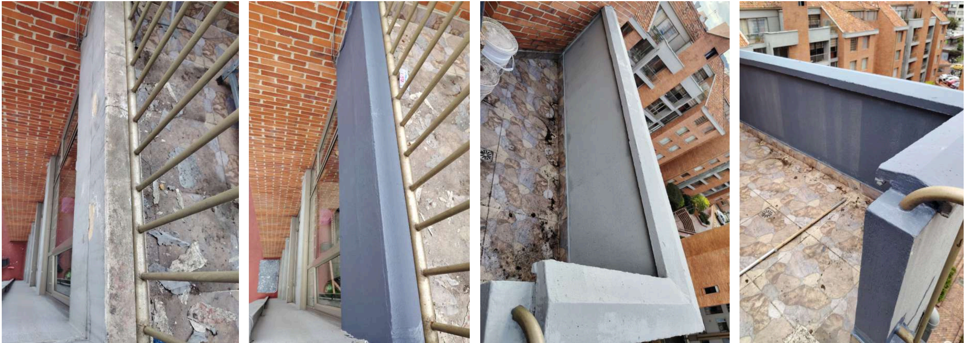
IMPERMEABILIZACIÓN ALFAGIAS FACHADA 10-501
