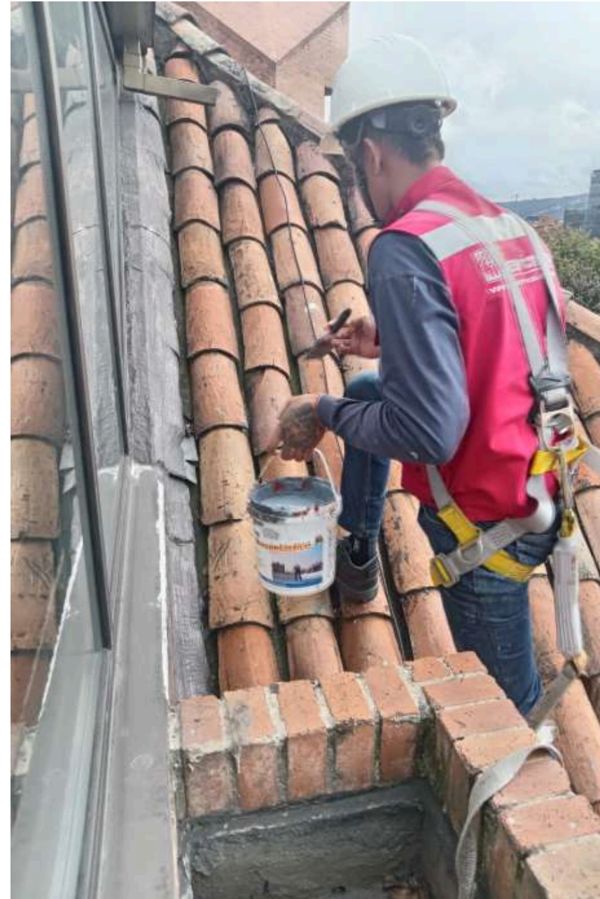
IMPERMEABILIZACIÓN MATERA Y TEJADO 6-503
