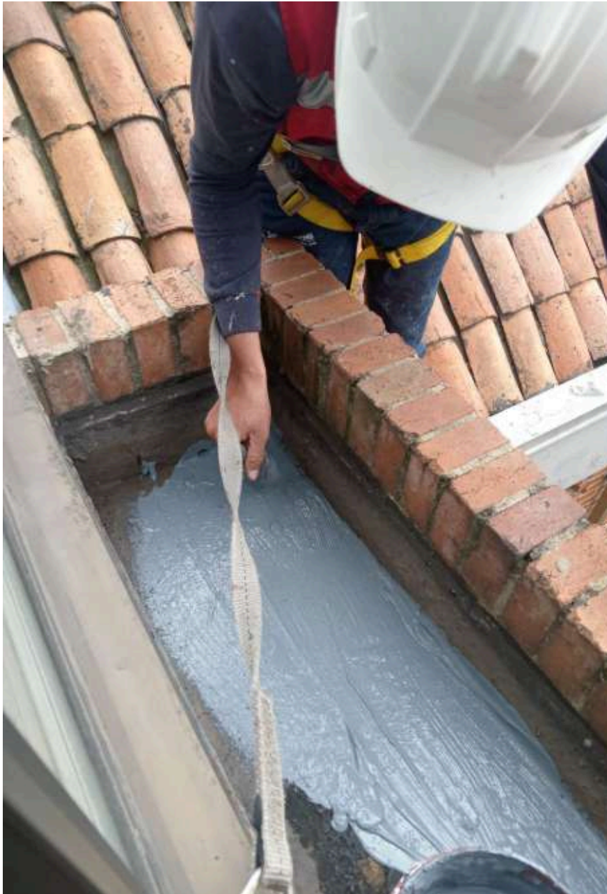
IMPERMEABILIZACIÓN MATERA Y TEJADO 6-503
