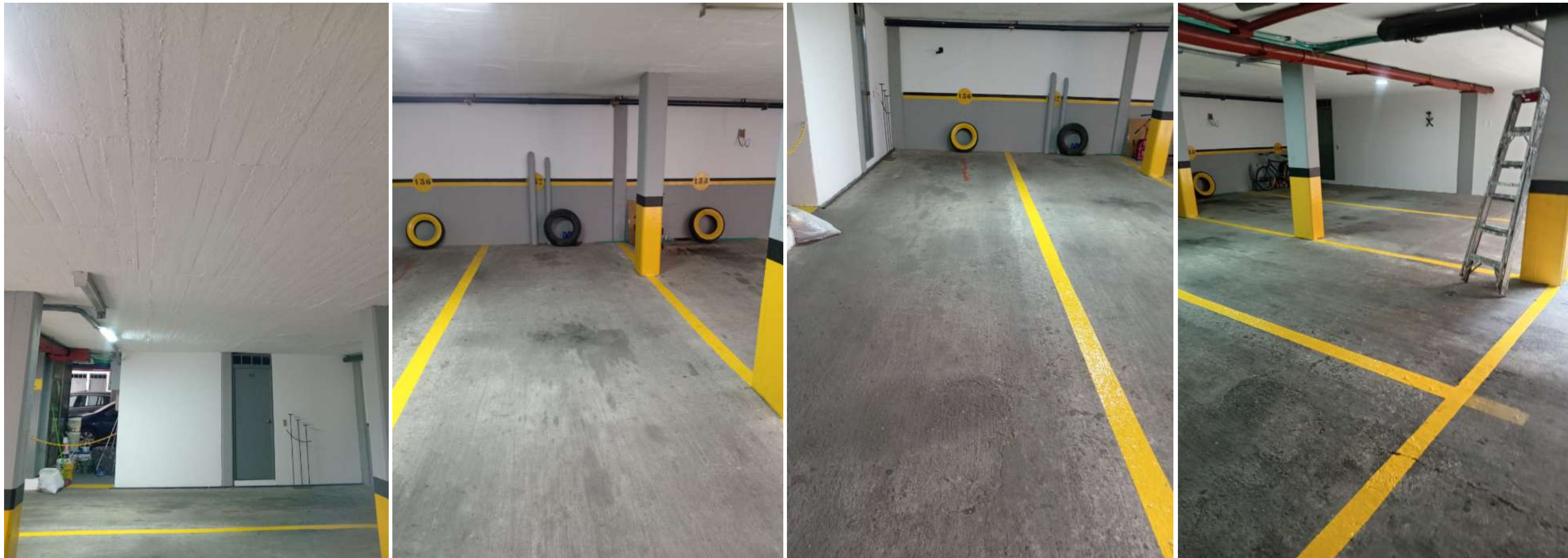
PINTURA E IMPERMEABILIZACIÓN PARQUEADEROS 136, 137, 138 y 139
