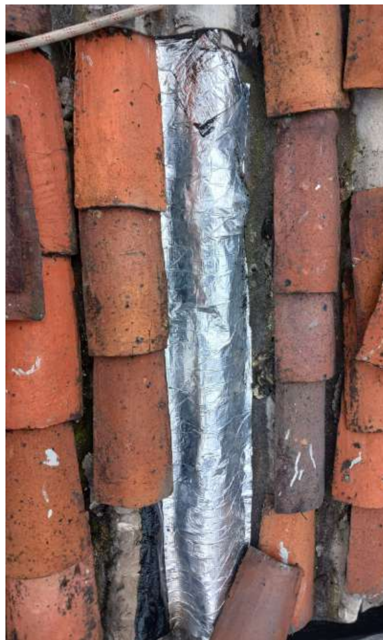
ARREGLO FISURA TEJA 6-504
