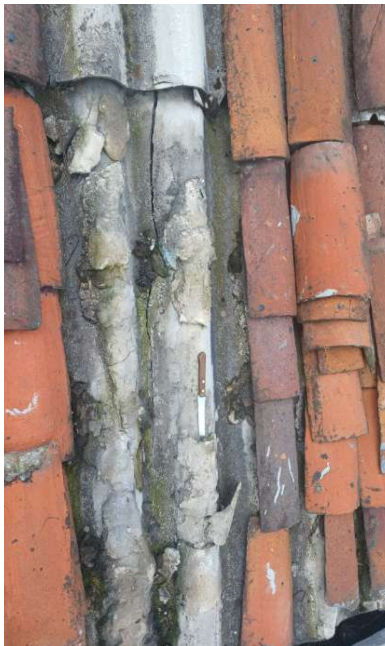
ARREGLO FISURA TEJA 6-504
