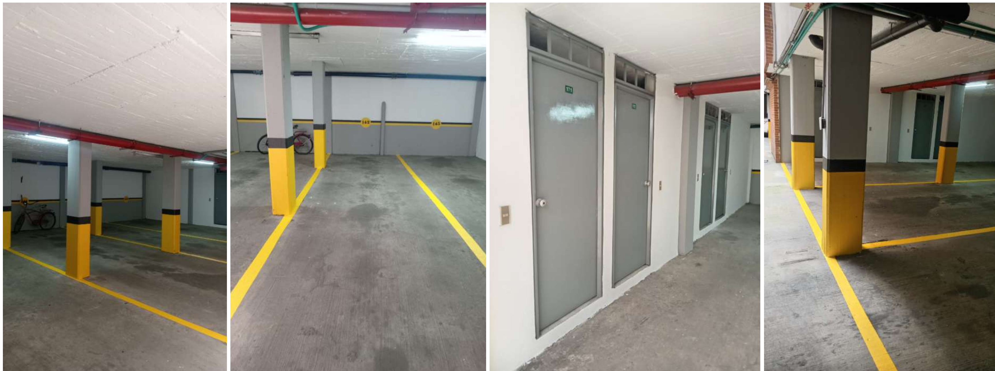
PINTURA E IMPERMEABILIZACIÓN PARQUEADEROS 140, 141, 142 y 143
