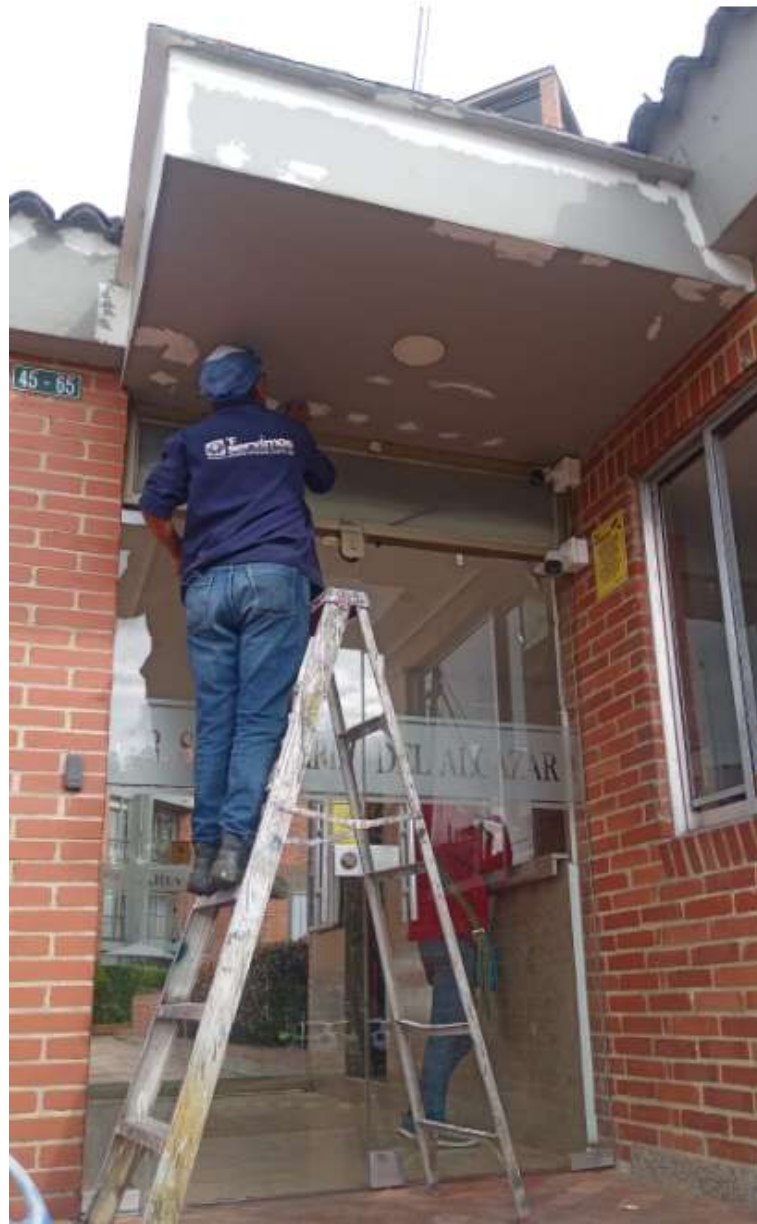
RESANE Y PINTURA FACHADA PORTERÍA NORTE
