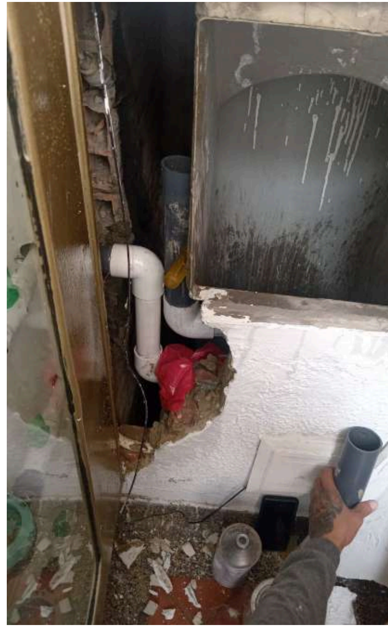
ROTURA DE TUBO DE AIREACION AGUA TORRE 9
