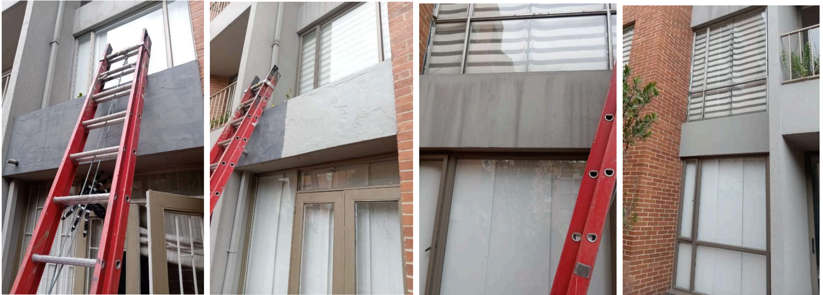
PINTURA DE FACHADAS IMPERMEABILIZADAS TORRES 6, 7, 8 Y 9
