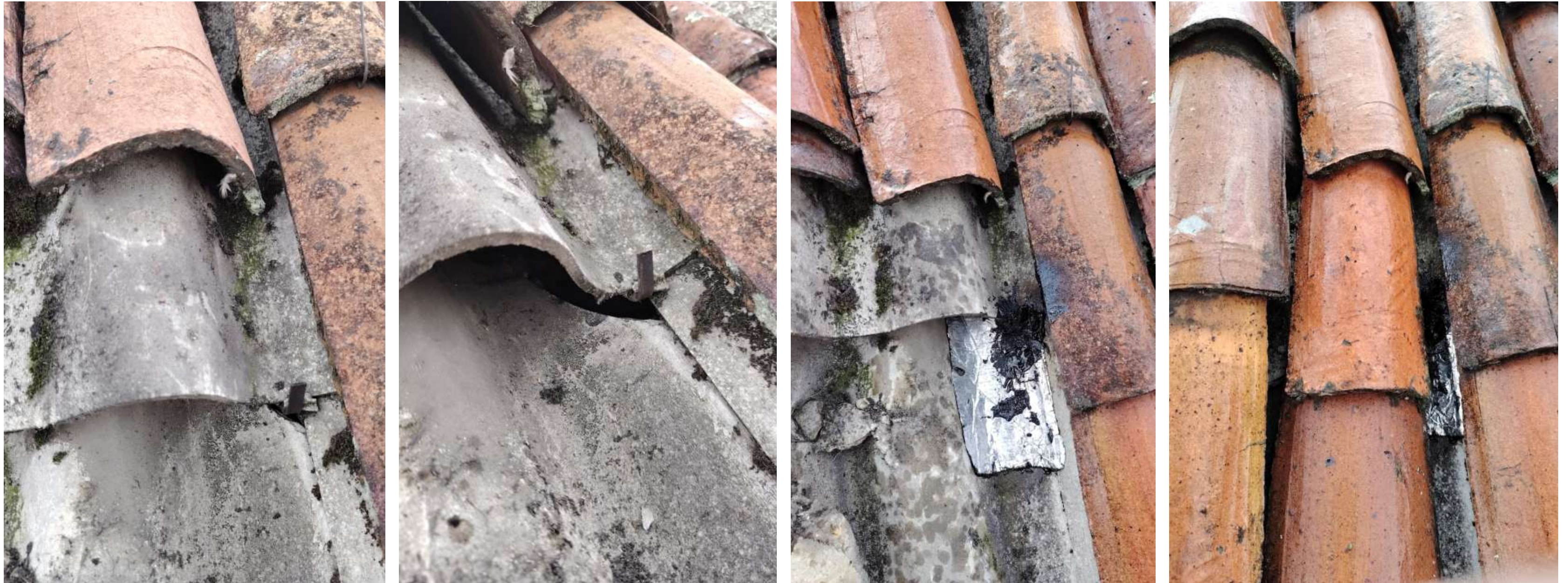
7-501 REPARCHEO TEJA POR GOTERA EN ALCOBA
