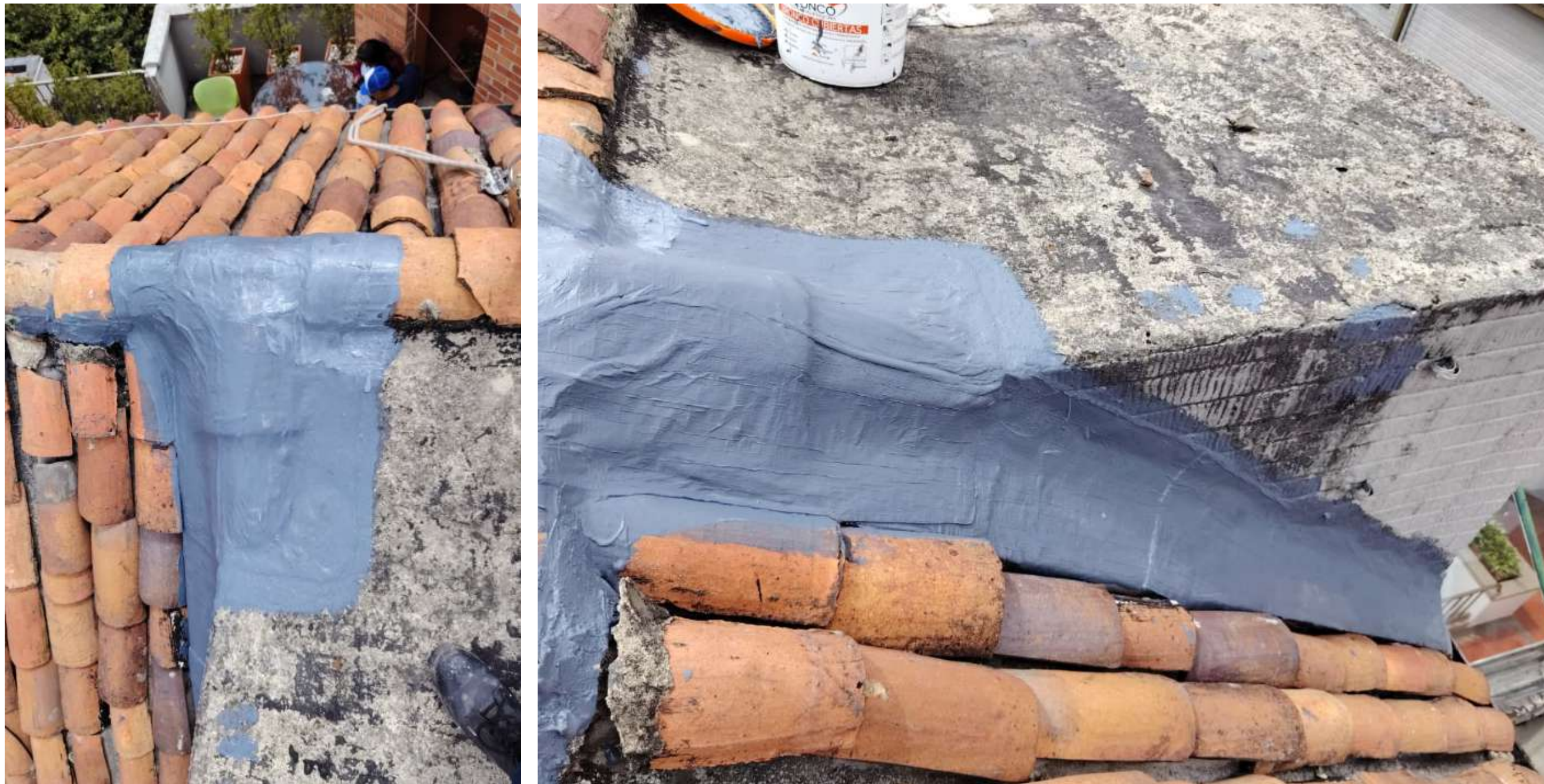
6-503 ARREGLO GOTERA ALCOBA PRINCIPAL
