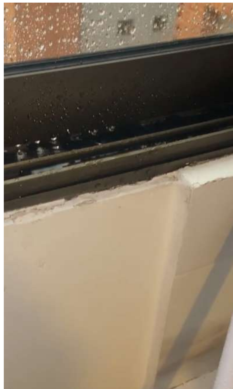
5-403 FILTRACIÓN DE AGUA EN MARCO DE VENTANA
