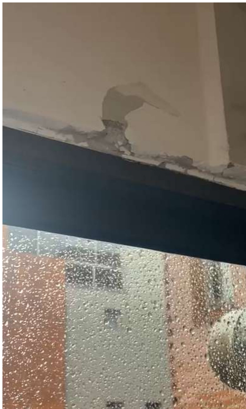
5-403 FILTRACIÓN DE AGUA EN MARCO DE VENTANA
