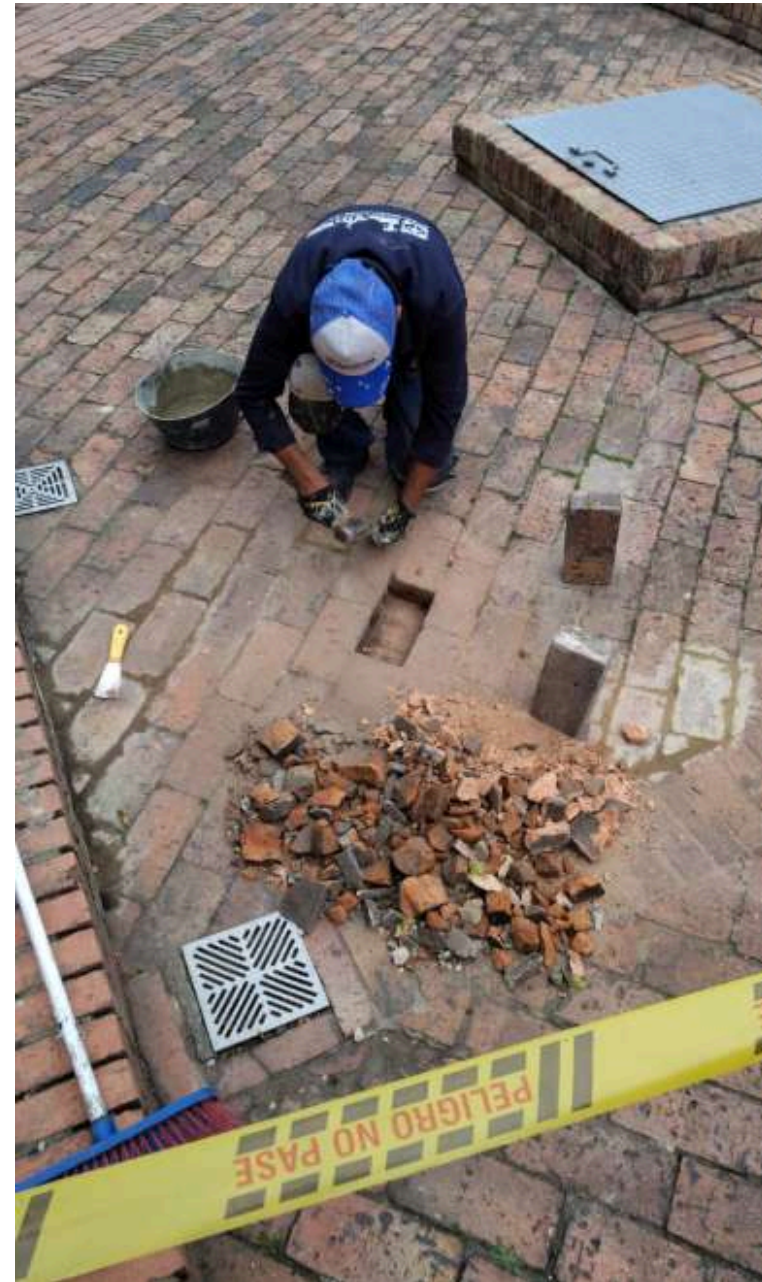
NIVELADO ADOQUINES PLAZOLETA
