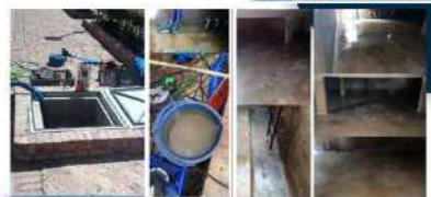
LAVADO DE TANQUE DE AGUA POTABLE
