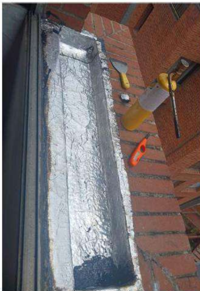
10-504 IMPERMEABILIZACIÓN MATERA
