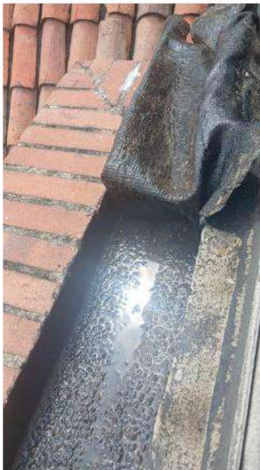
10-504 IMPERMEABILIZACIÓN MATERA
