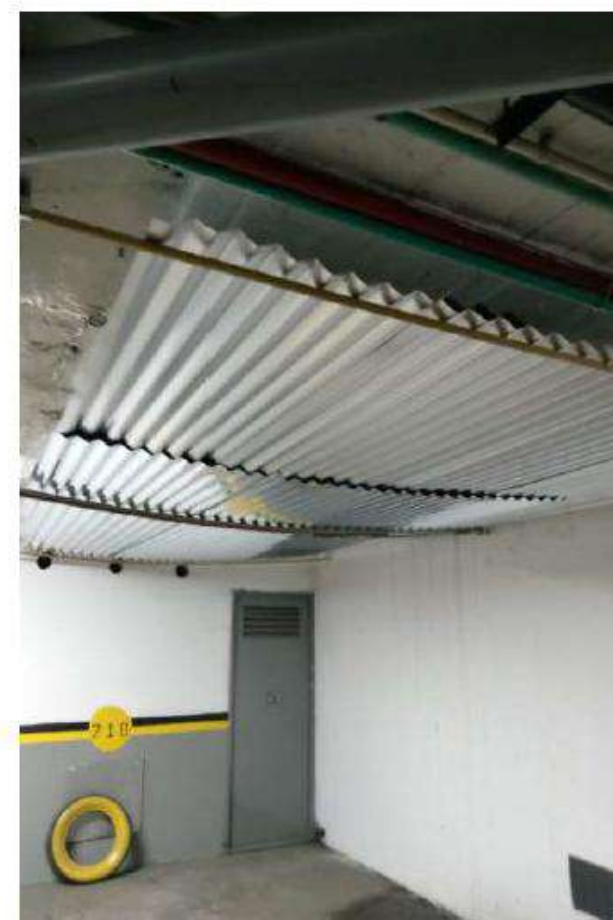
6-304 TECHADO EN ZIN POR FILTRACIÓN EN PARQUEADERO
