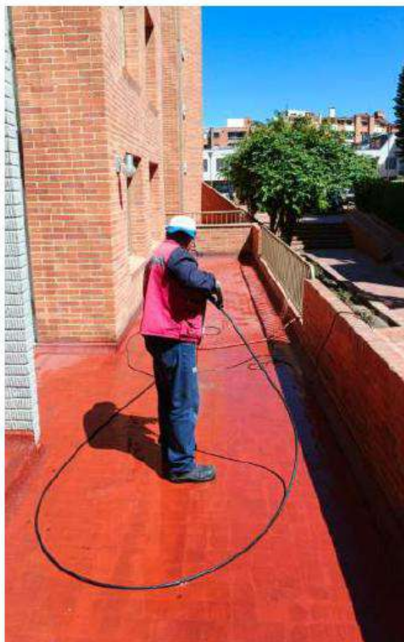
1-203 Se realiza impermeabilización de terraza 2-104
