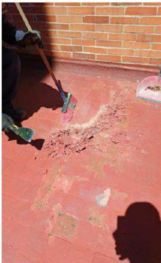
1-203 Se realiza impermeabilización de terraza 2-104
