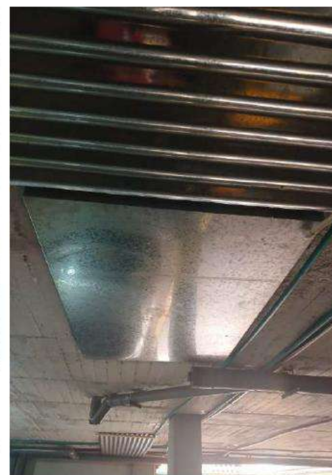
2-402 INSTALACIÓN BANDEJA POR FILTRACIÓN PARQUEADERO
