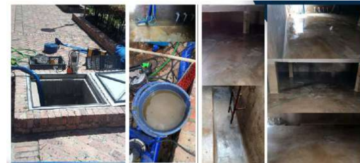
LAVADO DE TANQUE DE AGUA POTABLE
