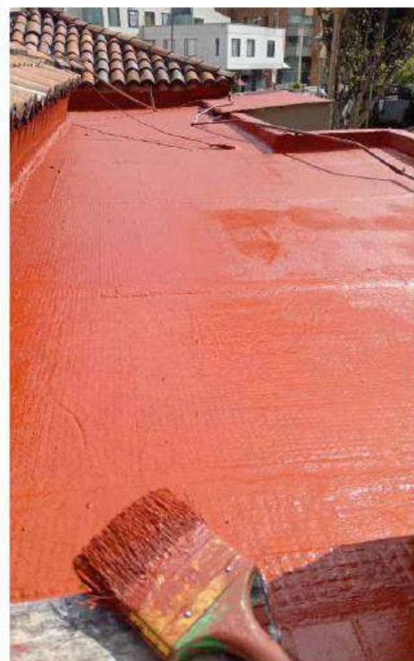
IMPERMEABILIZACIÓN PORTERÍA NORTE ANTES Y DESPUÉS
