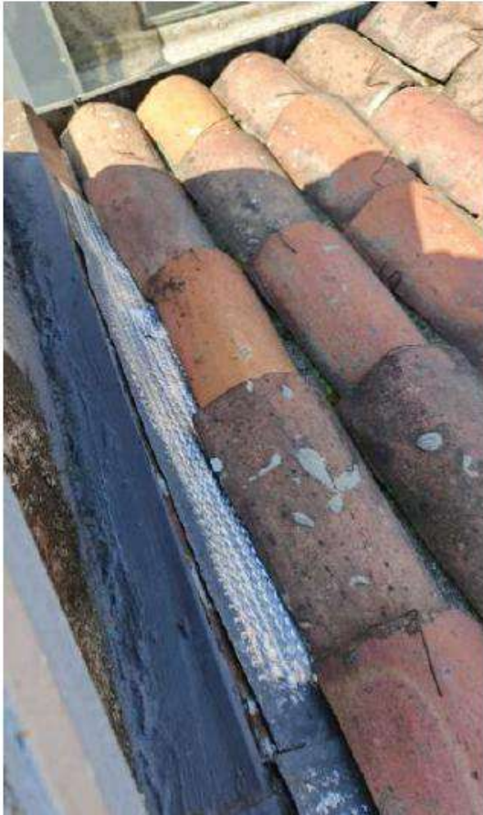
4-504 impermeabilización filtración en techo alcoba principal
