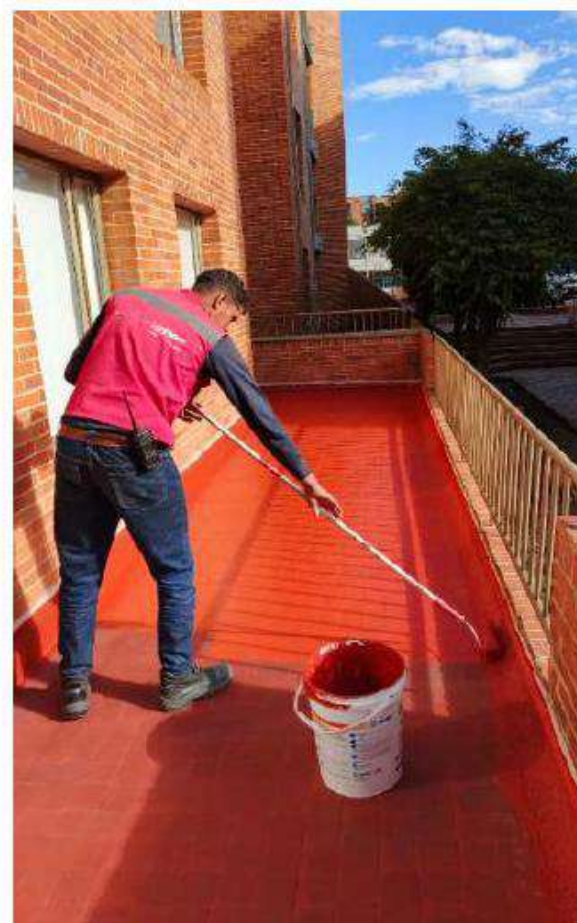
1-203 Se realiza impermeabilización de terraza 2-104
