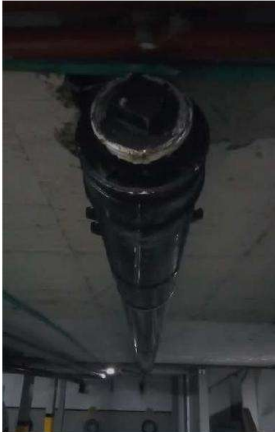
Arreglo filtración tubería de aguas negras
