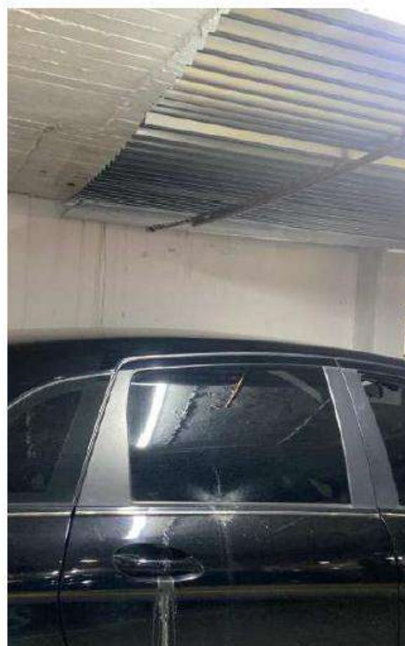
6-304 TECHADO EN ZIN POR FILTRACIÓN EN PARQUEADERO
