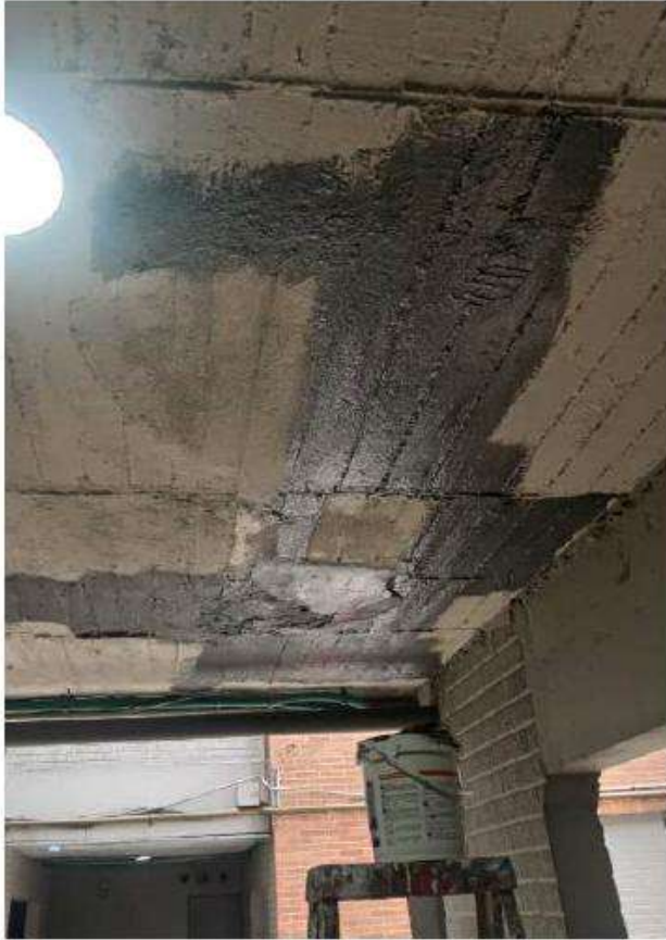
PINTURA E IMPERMEABILIZACIÓN PARQUEADEROS
