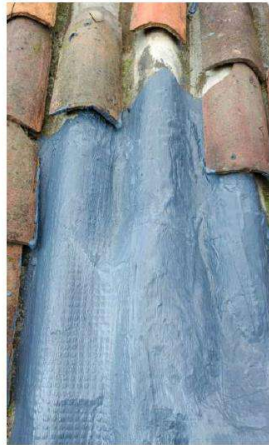
4-504 impermeabilización filtración en techo alcoba principal
