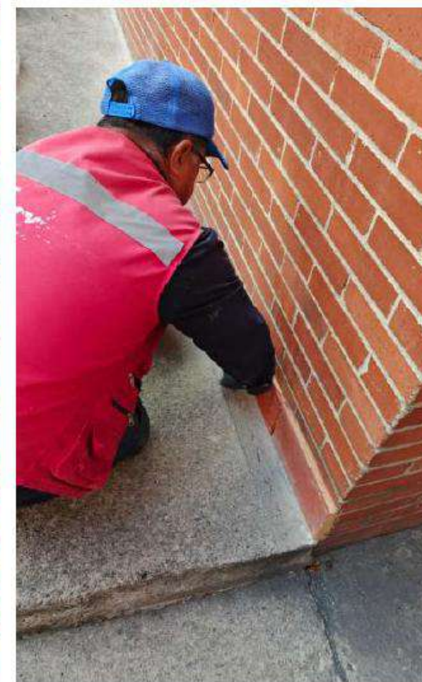
8-402 Emboquillada muro fachada por humedad en deposito #137
