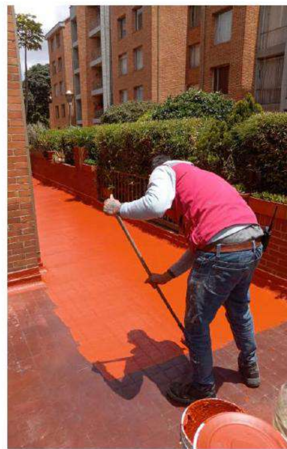
IMPERMEABILIZACIÓN TERRAZA 3-103
