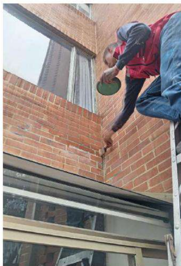
10-103 Y 10-203 IMPERMEABILIZACIÓN FACHADA HUMEDAD INTERNA
