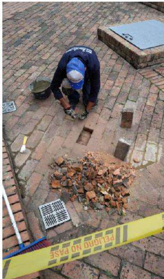
NIVELADO ADOQUINES PLAZOLETA
