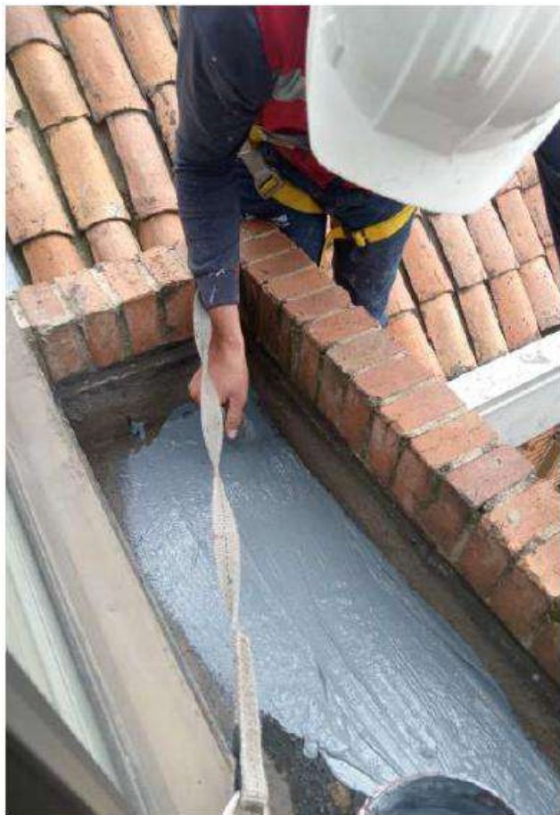
IMPERMEABILIZACIÓN MATERA Y TEJADO 6-503
