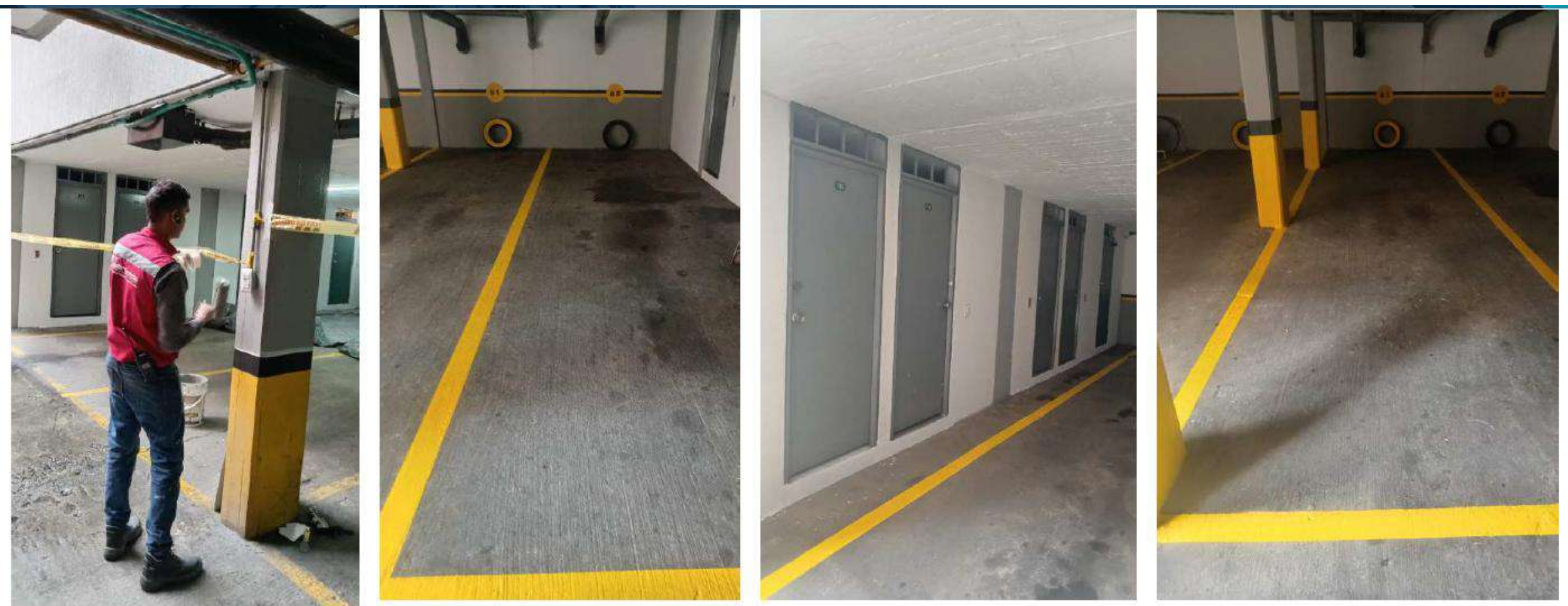
PINTURA E IMPERMEABILIZACIÓN PARQUEADEROS
