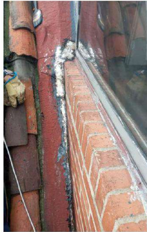
7-504 Impermeabilización techo por humedad en alcoba pequeña
