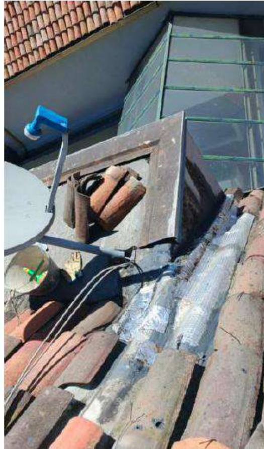
4-504 impermeabilización filtración en techo alcoba principal
