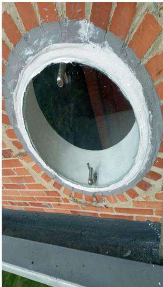
9-502 Impermeabilización ventanas
