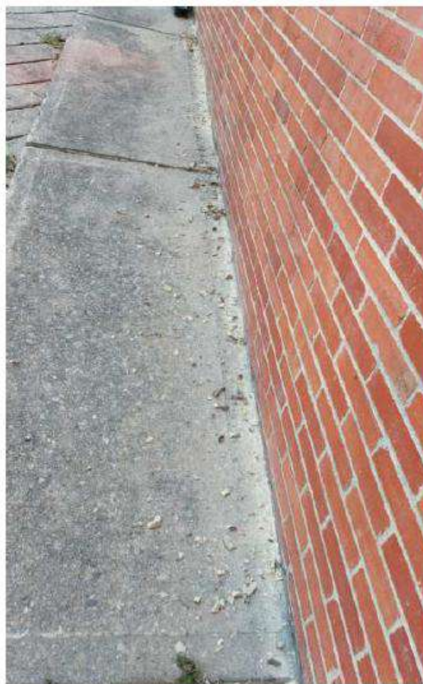
8-402 Emboquillada muro fachada por humedad en deposito #137
