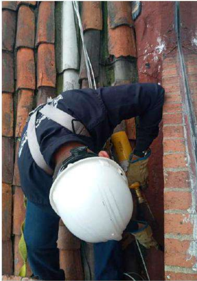
7-504 Impermeabilización techo por humedad en alcoba pequeña
