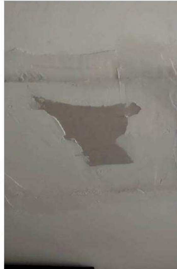
5-501 resane Drywall techo cocina por filtración ya reparada
