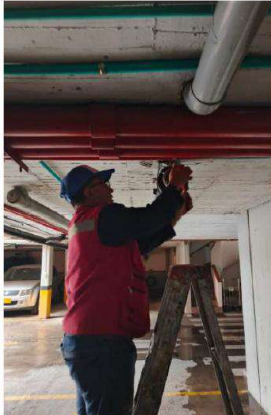
Arreglo filtración tubería de aguas negras
