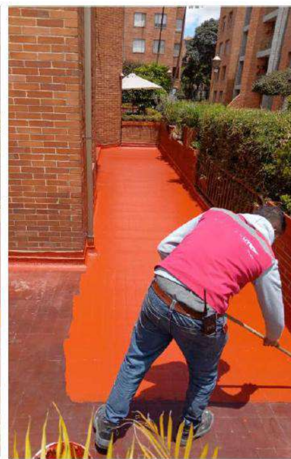
IMPERMEABILIZACIÓN TERRAZA 3-103
