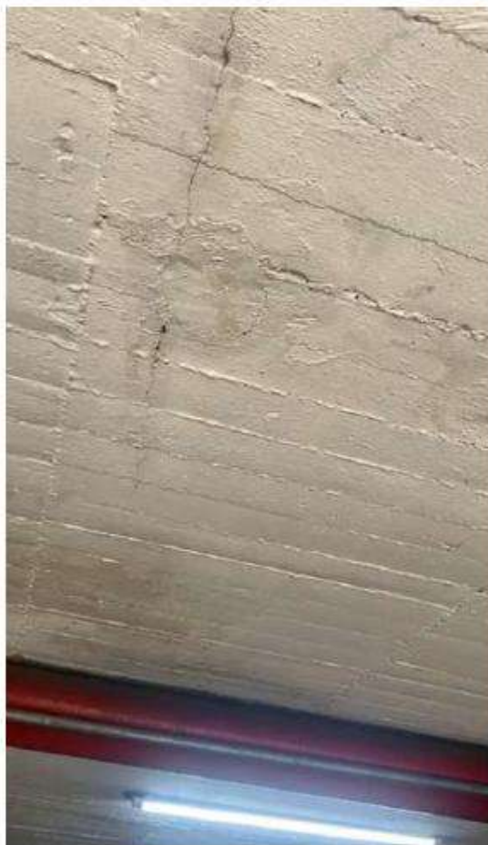
6-502 EXPLORACIÓN FILTRACIÓN EN PARQUEADERO #164
