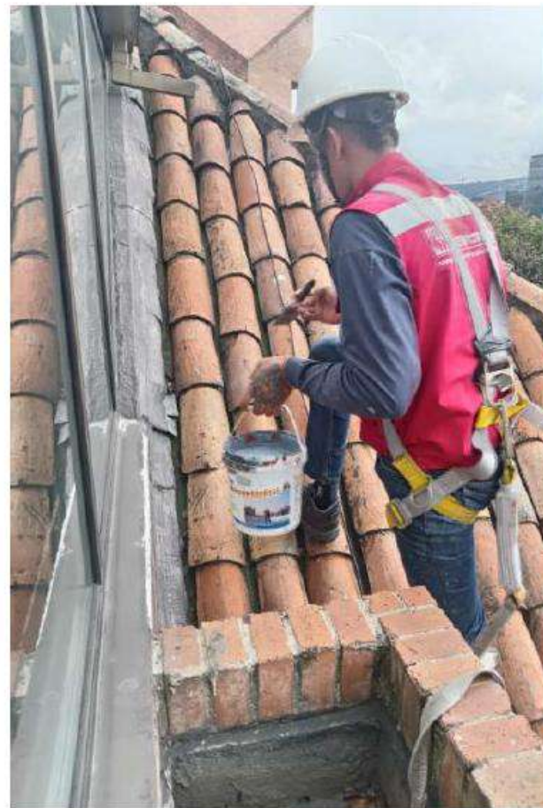
IMPERMEABILIZACIÓN MATERA Y TEJADO 6-503
