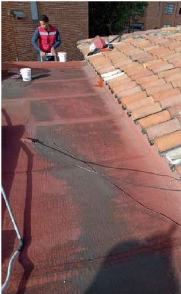
IMPERMEABILIZACIÓN PORTERÍA NORTE ANTES Y DESPUÉS
