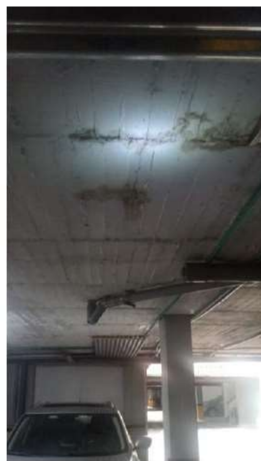
2-402 INSTALACIÓN BANDEJA POR FILTRACIÓN PARQUEADERO
