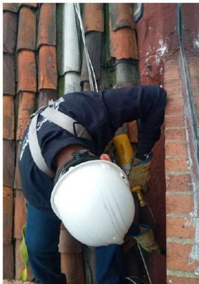
7-504 Impermeabilización techo por humedad en alcoba pequeña
