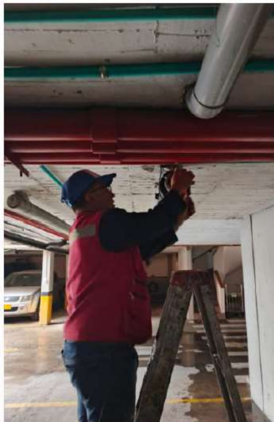
Arreglo filtración tubería de aguas negras
