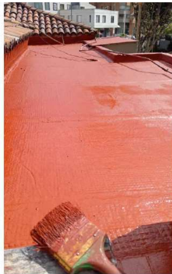
IMPERMEABILIZACIÓN PORTERÍA NORTE ANTES Y DESPUÉS
