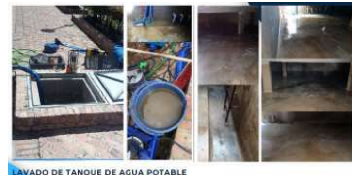
LAVADO DE TANQUE DE AGUA POTABLE
