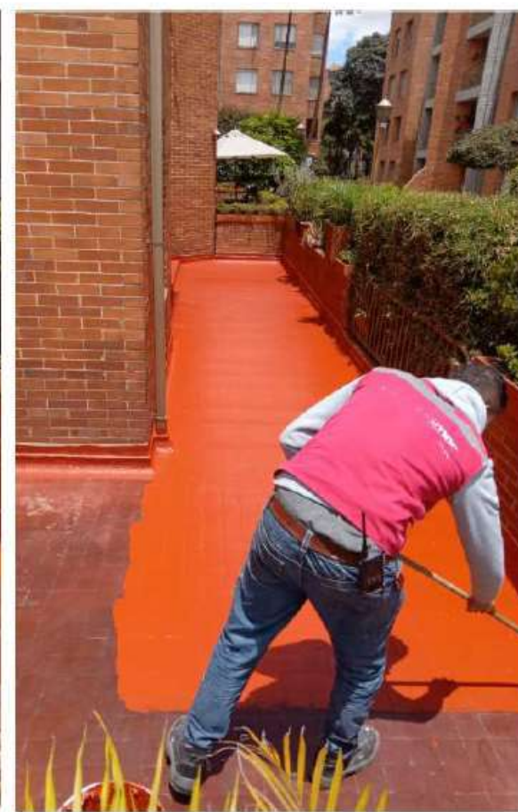
IMPERMEABILIZACIÓN TERRAZA 3-103
