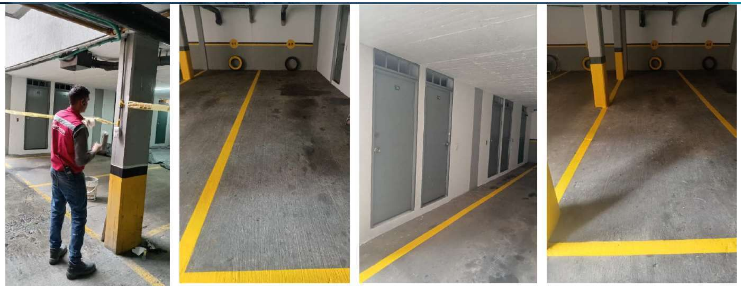
PINTURA E IMPERMEABILIZACIÓN PARQUEADEROS
