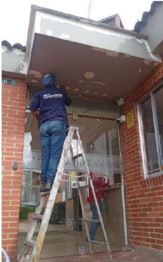
RESANE Y PINTURA FACHADA PORTERÍA NORTE
