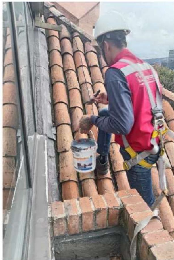
IMPERMEABILIZACIÓN MATERA Y TEJADO 6-503
