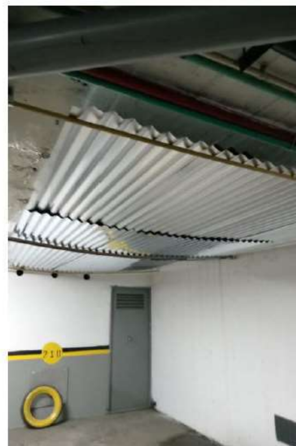
6-304 TECHADO EN ZIN POR FILTRACIÓN EN PARQUEADERO
