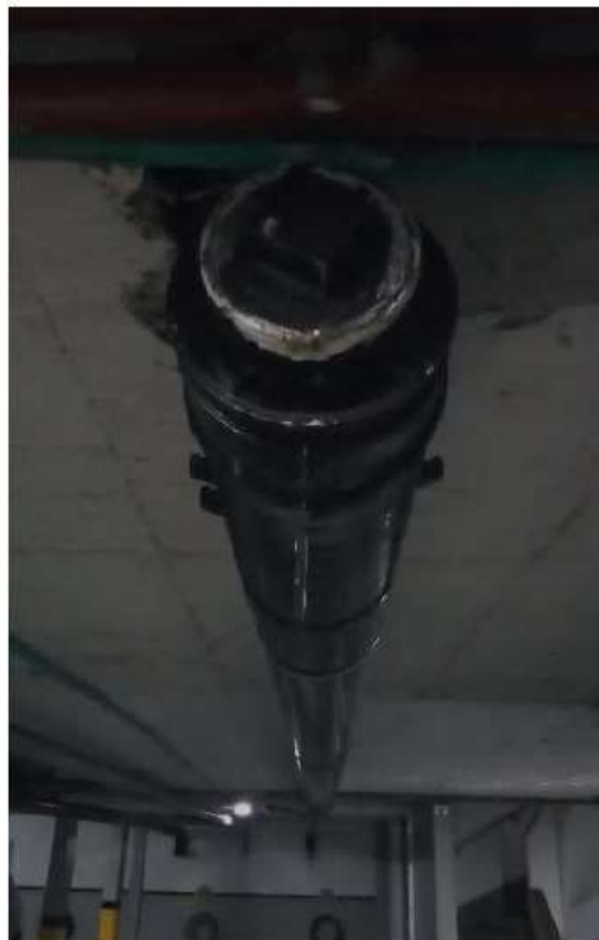
Arreglo filtración tubería de aguas negras
