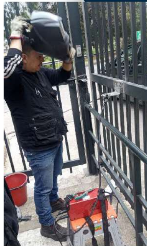
INSTALACIÓN BRAZOS ELECTROMECHANICOS PORTERIA SUR
