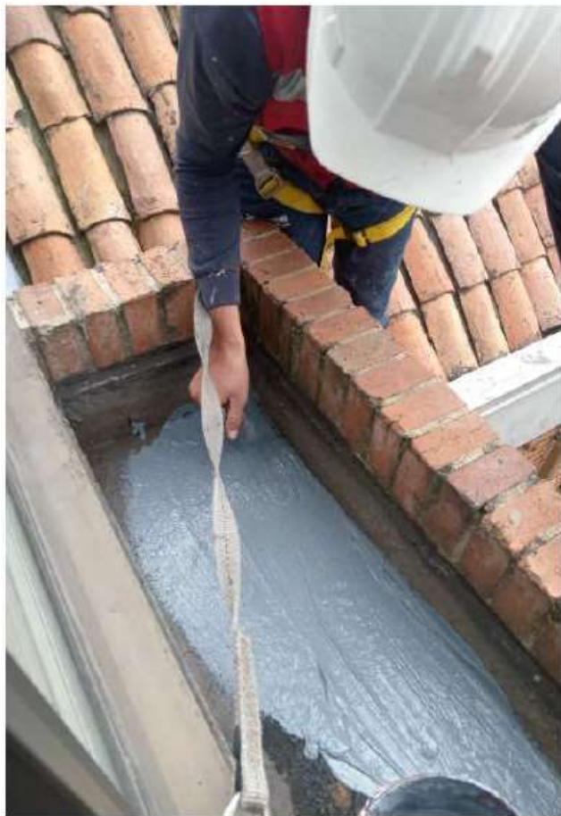
IMPERMEABILIZACIÓN MATERA Y TEJADO 6-503
