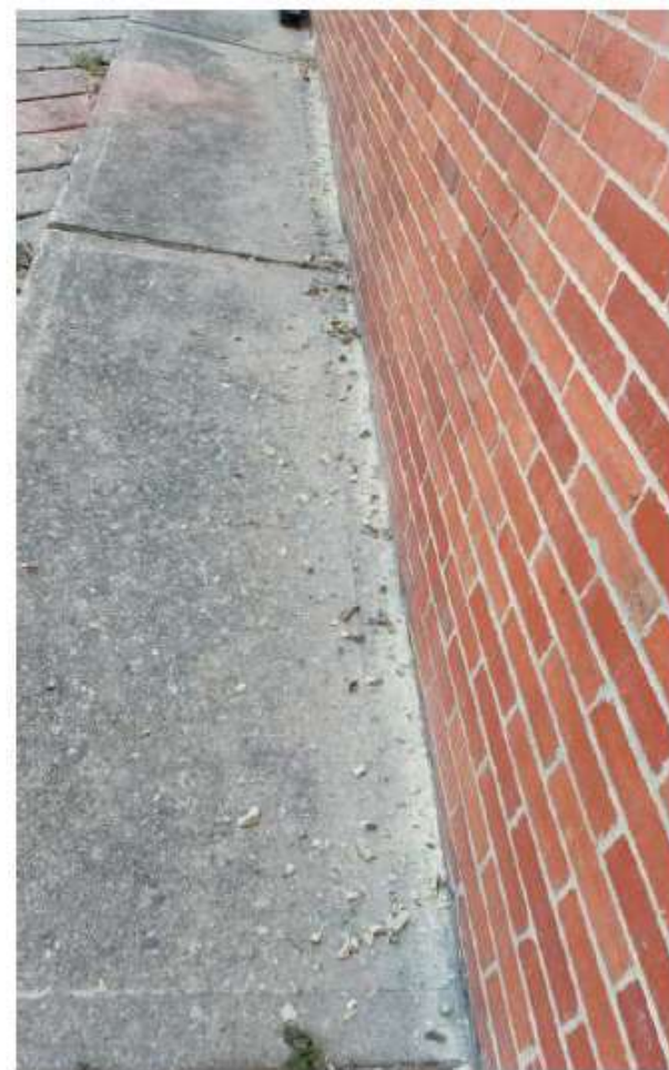
8-402 Emboquillada muro fachada por humedad en deposito #137
