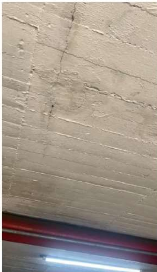
6-502 EXPLORACIÓN FILTRACIÓN EN PARQUEADERO #164
