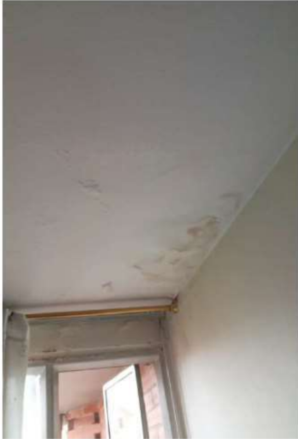
6-504 FILTRACIÓN ALCOBA Y JARDINERA
