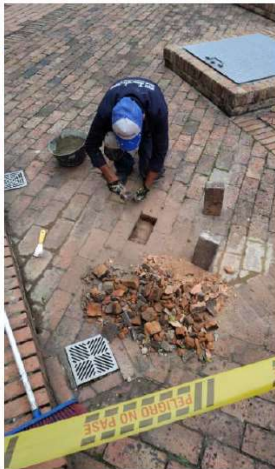
NIVELADO ADOQUINES PLAZOLETA
