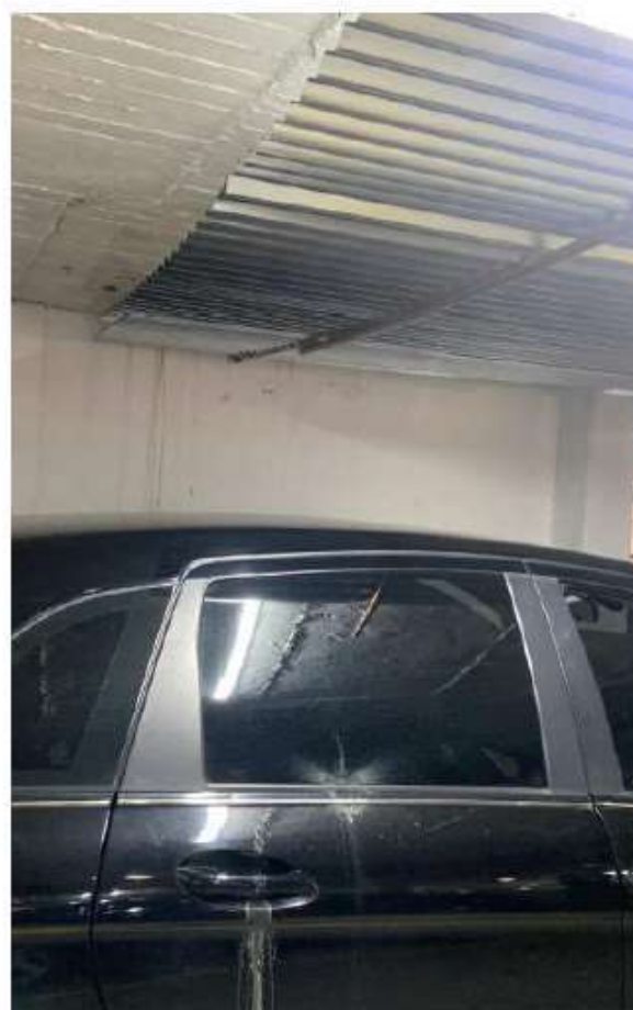
6-304 TECHADO EN ZIN POR FILTRACIÓN EN PARQUEADERO
