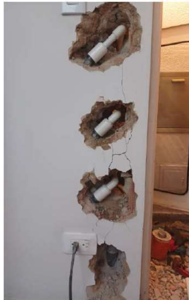
CAMBIO DE TUBERÍA GALVANIZADA A PVC REGISTROS DE AGUA
