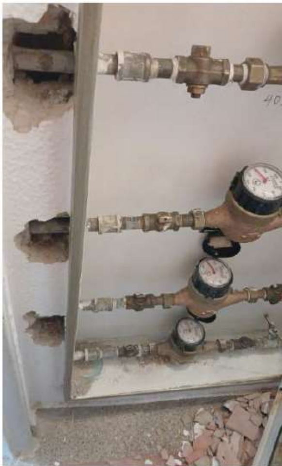
CAMBIO DE TUBERÍA GALVANIZADA A PVC REGISTROS DE AGUA
