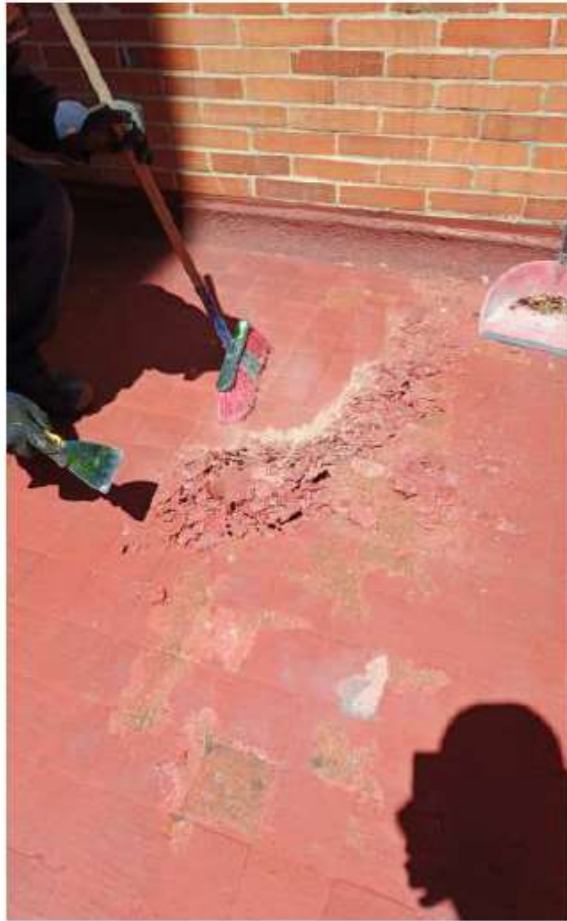
1-203 Se realiza impermeabilización de terraza 2-104
