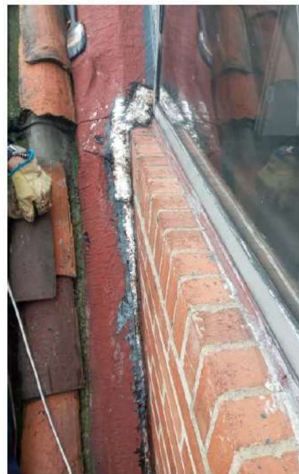
7-504 Impermeabilización techo por humedad en alcoba pequeña
