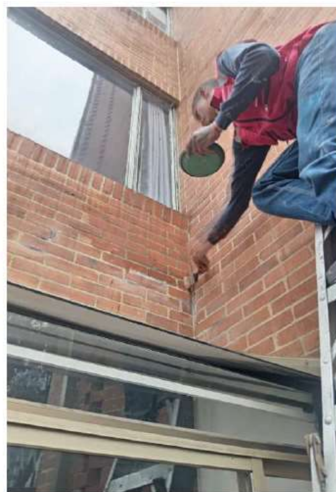
10-103 Y 10-203 IMPERMEABILIZACIÓN FACHADA HUMEDAD INTERNA
