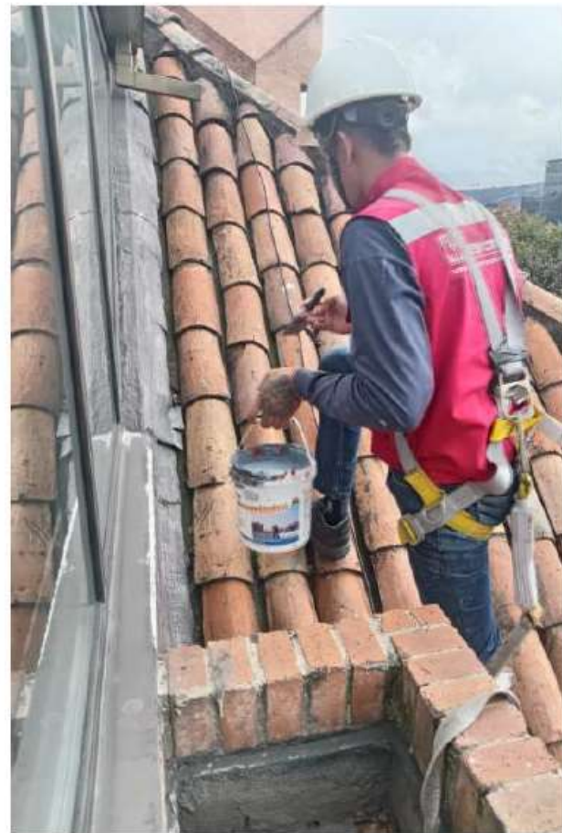
IMPERMEABILIZACIÓN MATERA Y TEJADO 6-503
