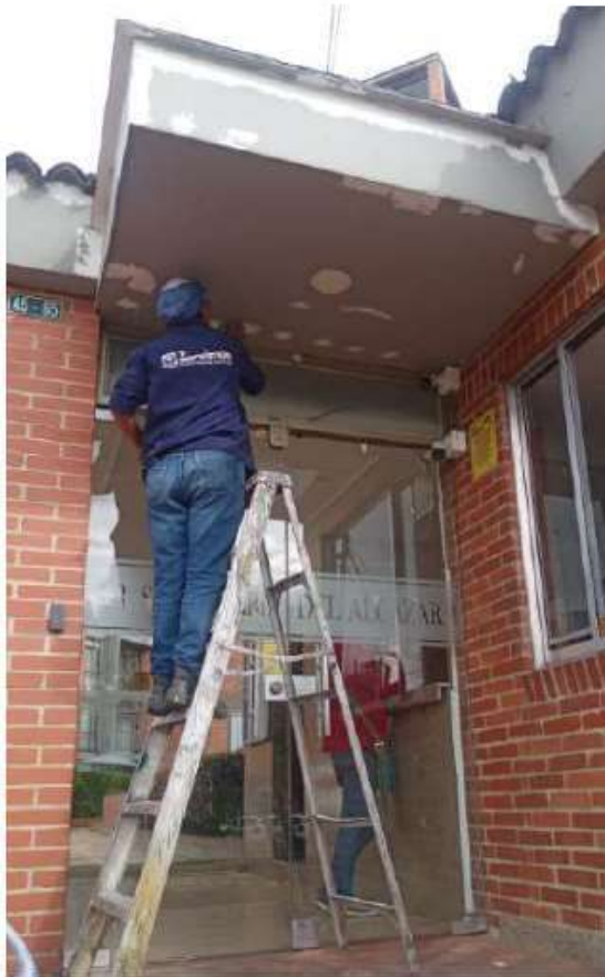
RESANE Y PINTURA FACHADA PORTERÍA NORTE
