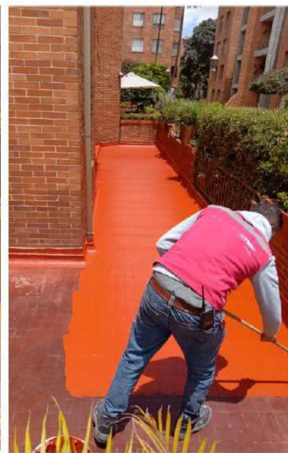
IMPERMEABILIZACIÓN TERRAZA 3-103
