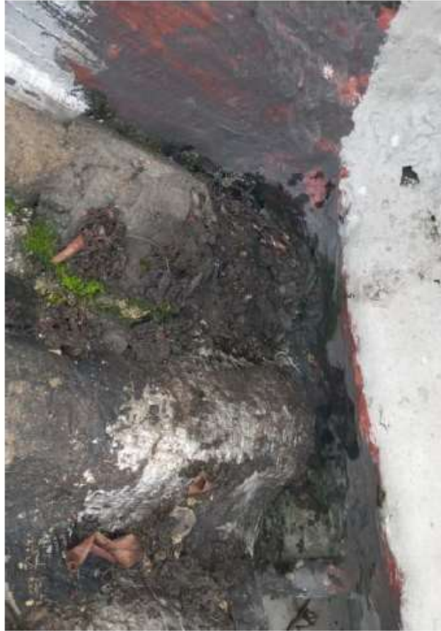
6-504 FILTRACIÓN ALCOBA Y JARDINERA
