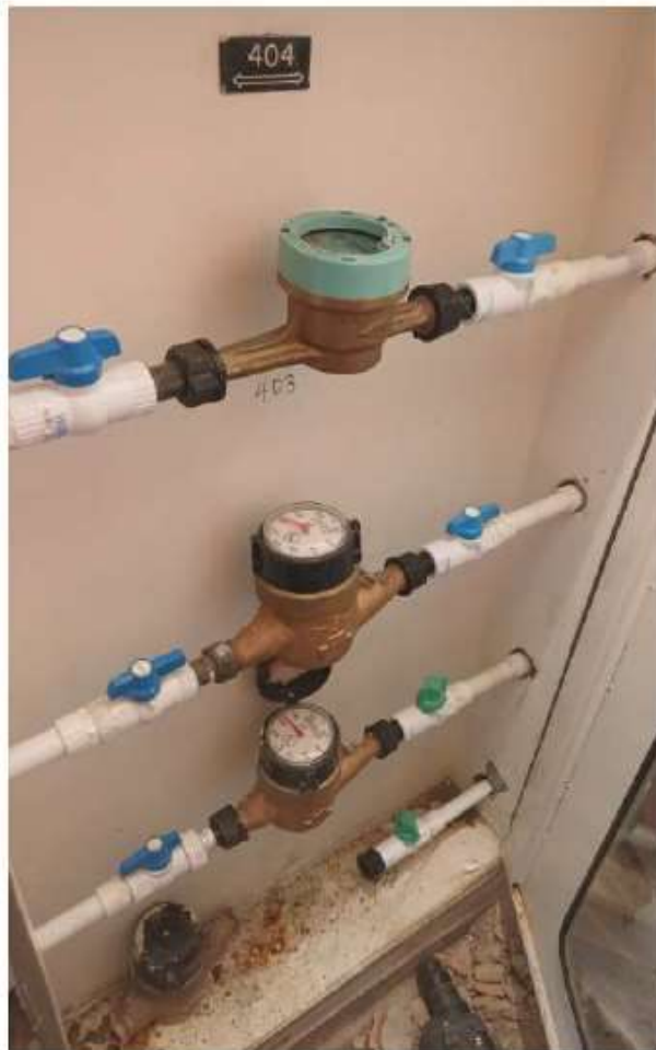
CAMBIO DE TUBERÍA GALVANIZADA A PVC REGISTROS DE AGUA
