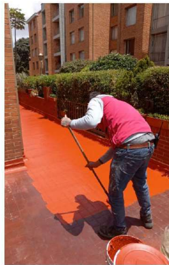
IMPERMEABILIZACIÓN TERRAZA 3-103
