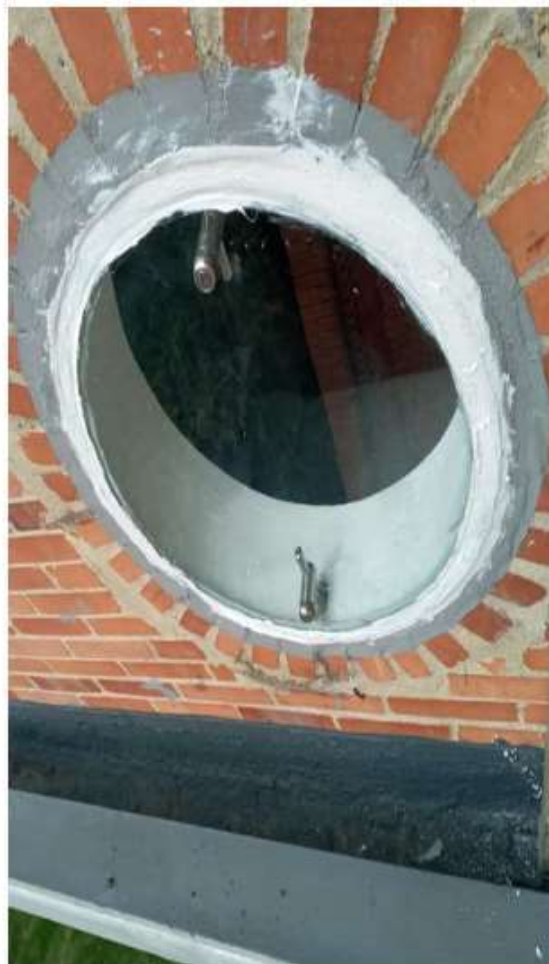
9-502 Impermeabilización ventanas
