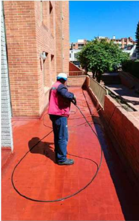
1-203 Se realiza impermeabilización de terraza 2-104
