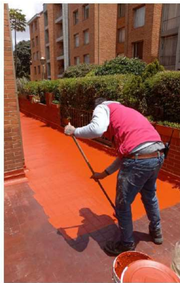
IMPERMEABILIZACIÓN TERRAZA 3-103
