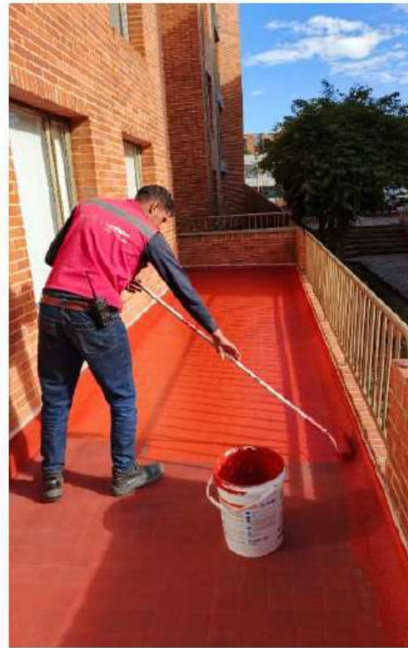
1-203 Se realiza impermeabilización de terraza 2-104
